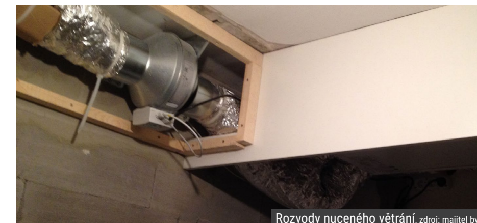
Rekuperátor a rozvody nuceného větrání pod stropem koupelny, zdroj: majitel bytu
