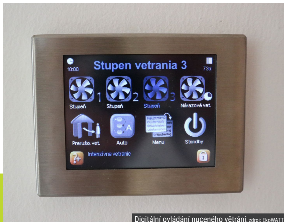
Digitální ovládání nuceného větrání, zdroj: EkoWATT
