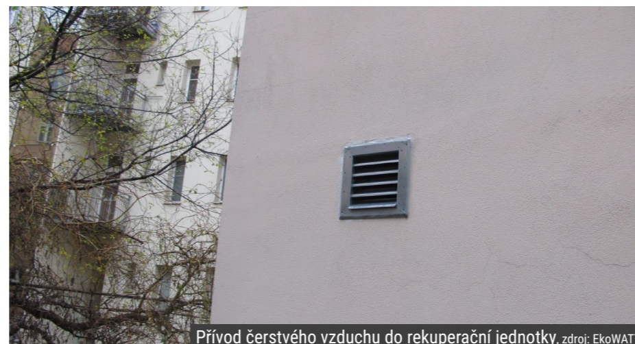
Přívod čerstvého vzduchu do rekuperační jednotky, zdroj: EkoWATT
