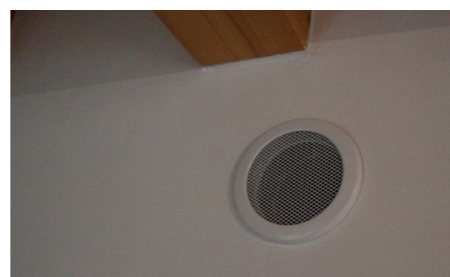
Odvod vzduchu z kuchyně, zdroj: EkoWATT
