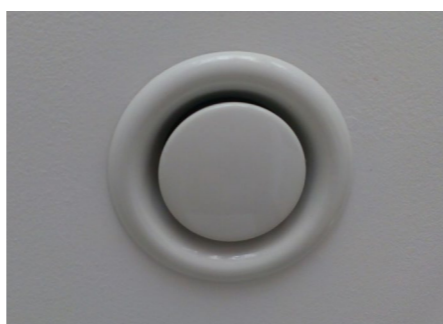
Vyústek nuceného větrání v interiéru zdroj: EkoWATT
