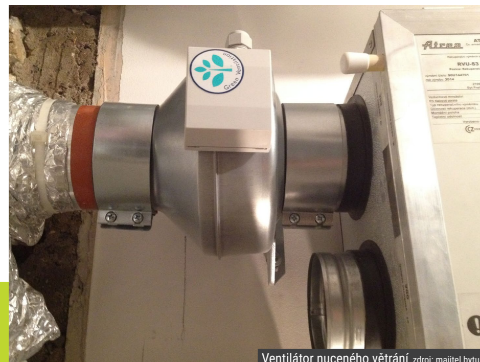
Ventilátor nuceného větrání, zdroj: majitel bytu
