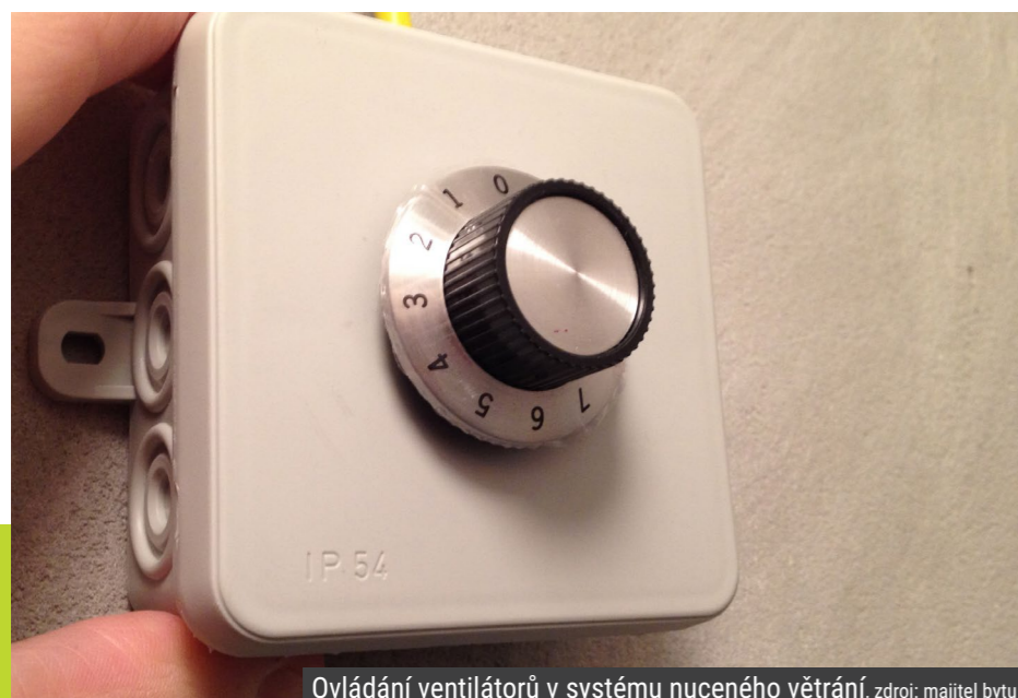
Ovládání ventilátorů v systému nuceného větrání, zdroj: majitel bytu
