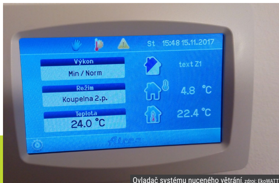
Ovladač systému nuceného větrání, zdroj: EkoWATT
