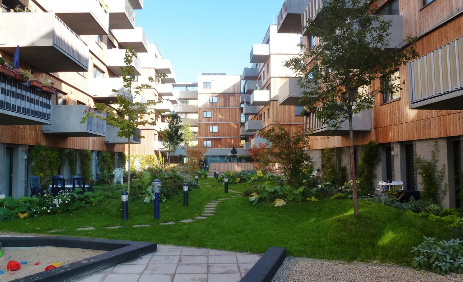
Kompaktní obytná skupina u ulice Maria Tusch Strasse. Úprava předzahrádek k jednotlivým bytům – bez oplocení. Jezerní město Aspern.
