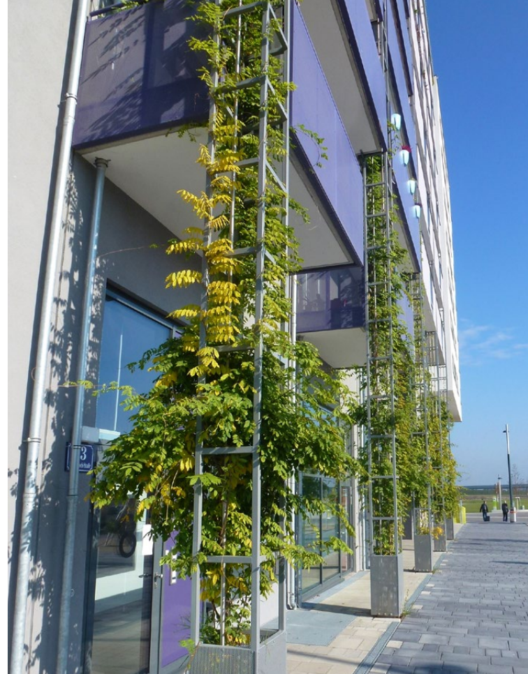
Vertikální zelené fasády, šplhavá zeleň napájená ze svodů vody z ploché střechy bytového domu. Jezerní město Aspern.
