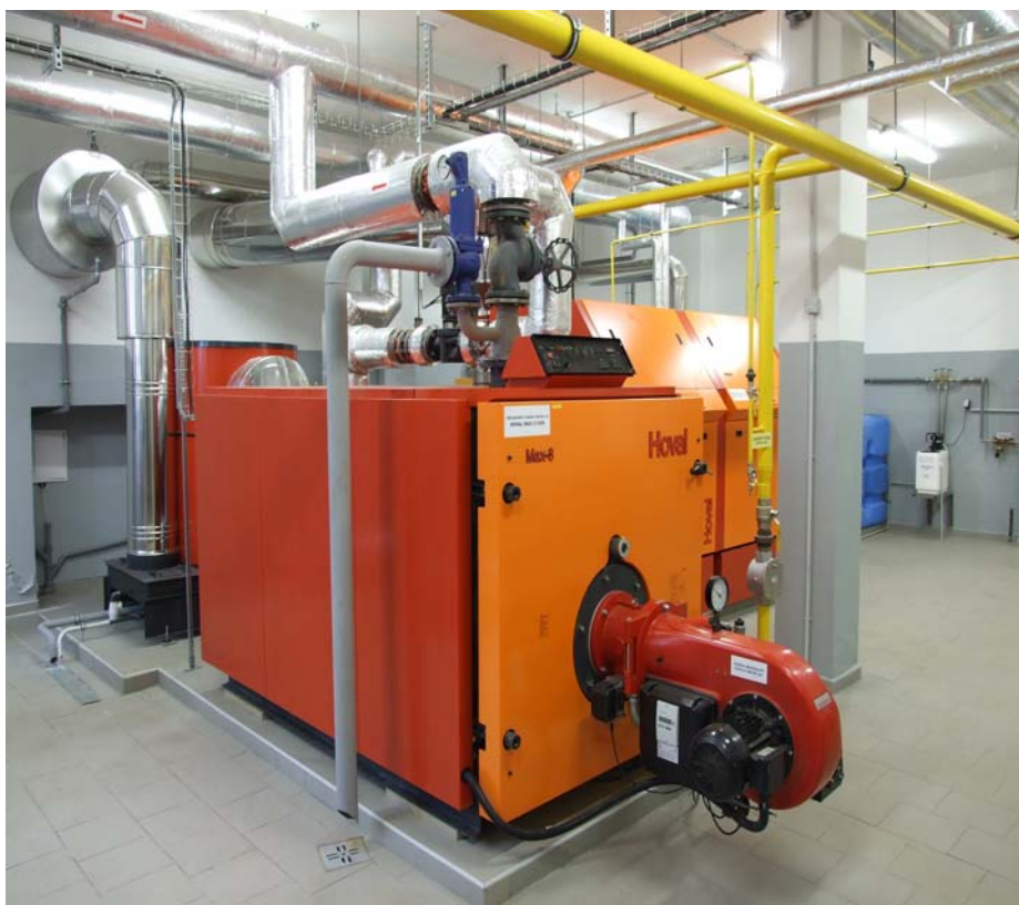
Pohled na kotel Hoval s dochlazovačem spalin
