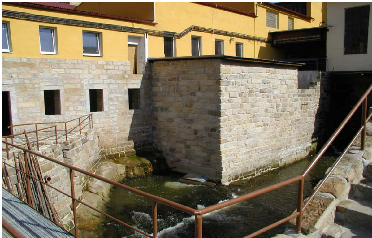
Celkový pohled na objekt MVE s vývařištem a odpadním kanálem
