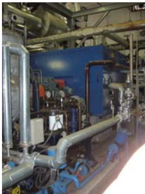
turbosoustrojí – protitlak. část
