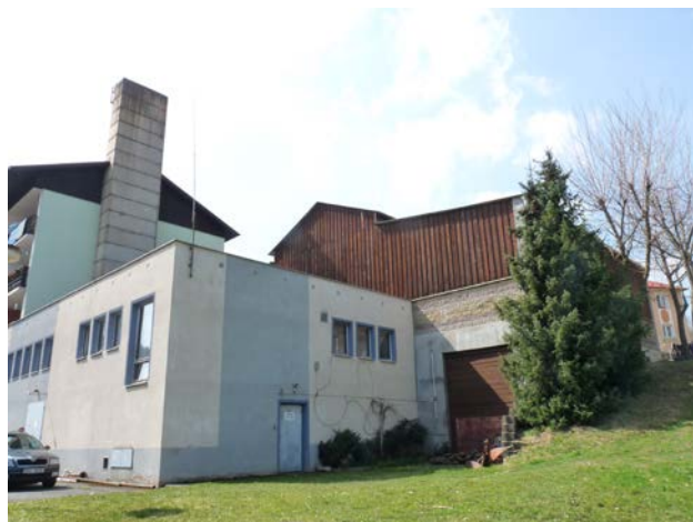
Obrázek 4 - Centrální kotelna sídliště v Hartmanicích K I
