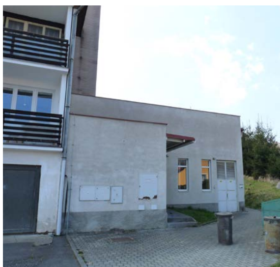
Obrázek 5 - Centrální kotelna sídliště v Hartmanicích K II
