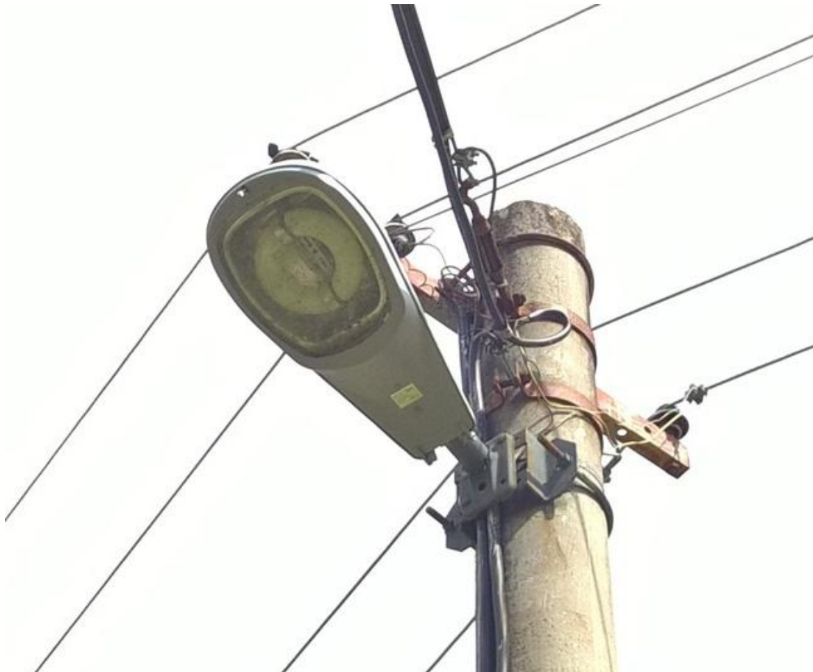
Obrázek 4 Svítidlo VO s indukční výbojkou na sloupu NN (foto: Theodor Terrich)
