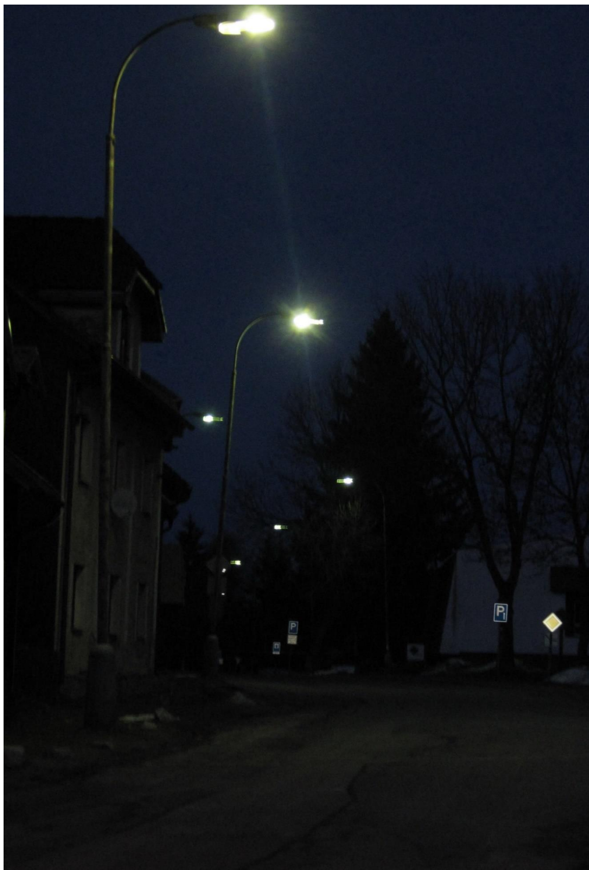
Obrázek 27 Technicky i fyzicky zastaralé VO v obci není schopno zajistit požadované světelné technické parametry na vozovce (foto: Theodor Terrich)
