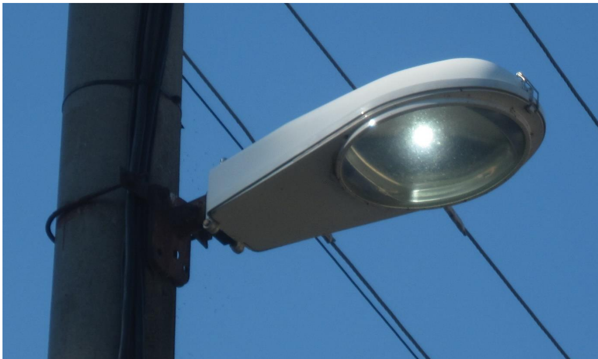
Obrázek 17 Svítidlo VO s jedním COB LED čipem (foto: Theodor Terrich)
