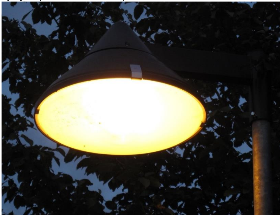
Obrázek 8 Designové svítidlo s integrovaným výložníkem osazené vysokotlakou sodíkovou výbojkou (foto: Theodor Terrich)
