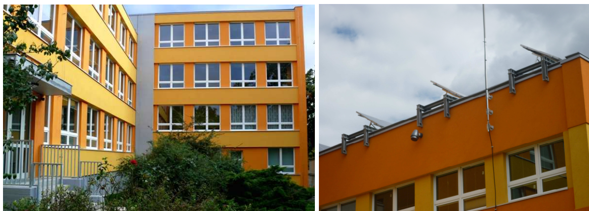
Obr. 8 Administrativní budova – po realizaci opatření
