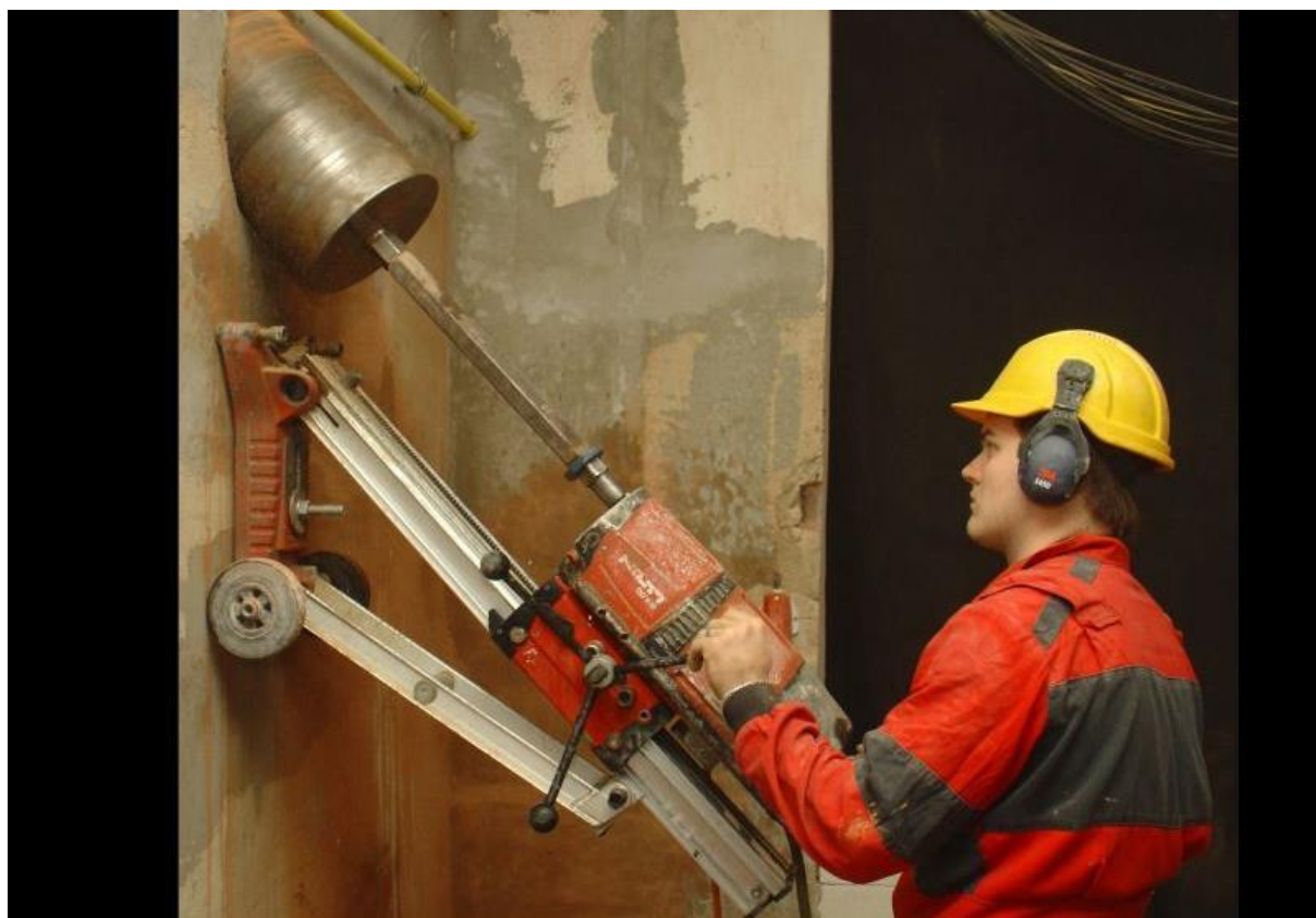
Obrázek 81 Ukázka jádrového vrtání otvorů pro vyústění vzduchotechnických rozvodů při komplexní renovaci budovy (zdroj: Diamond Experts s.r.o.)
