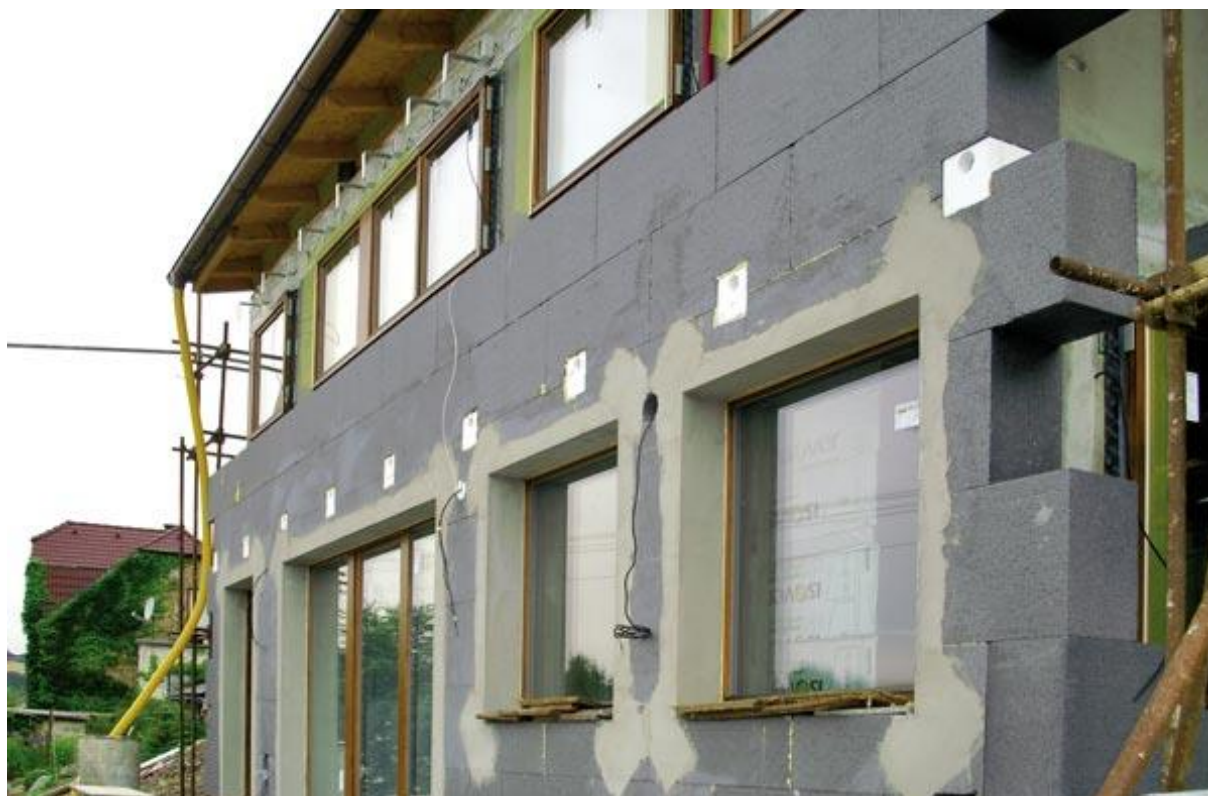
Obrázek 76 Ilustrační foto kvalitně provedeného zateplení
