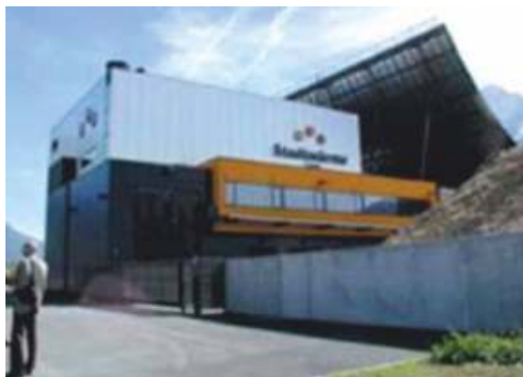
Obrázek 7 - Budova elektrárny v Lienz (Bios-Energy, 2001; převzato z Mydlil, 2010)
