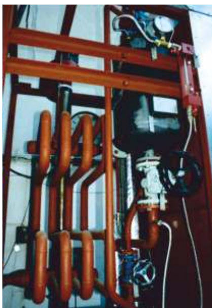
Obrázek 18 Nouzový výměník a expanzní nádoba I. okruhu (převzato z Maščuch, 2011)
