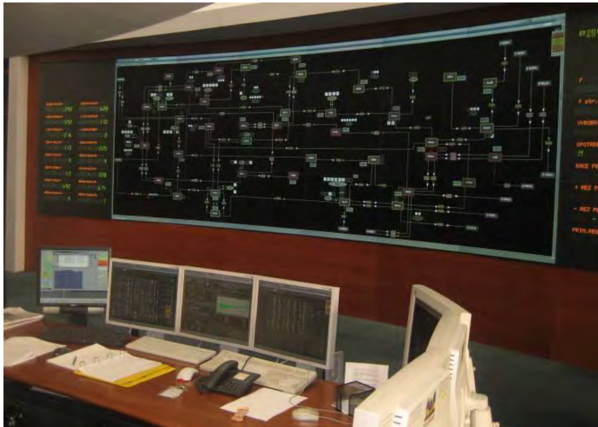
Obrázek 25.2. Hlavní obrazovka řídicího systému české přenosové soustavy.
