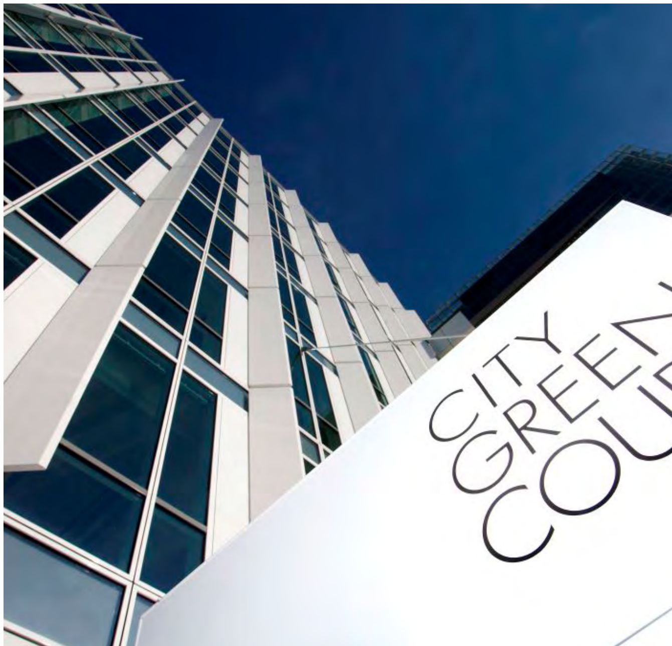
City Green Court v Praze - stínící vertikální lamely na kancelářské budově (Zdroj: Skanska Property)
