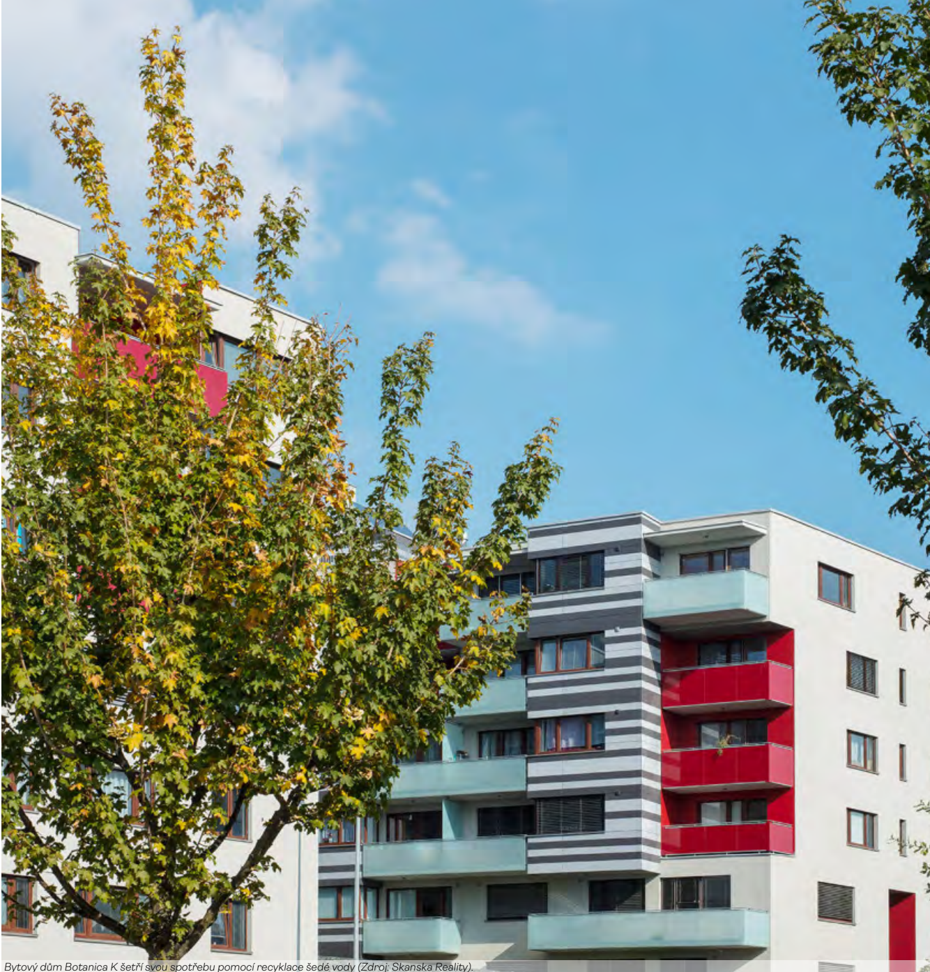
Bytový dům Botanica K šetří svou spotřebu pomocí recyklace šedé vody (Zdroj: Skanska Reality).
