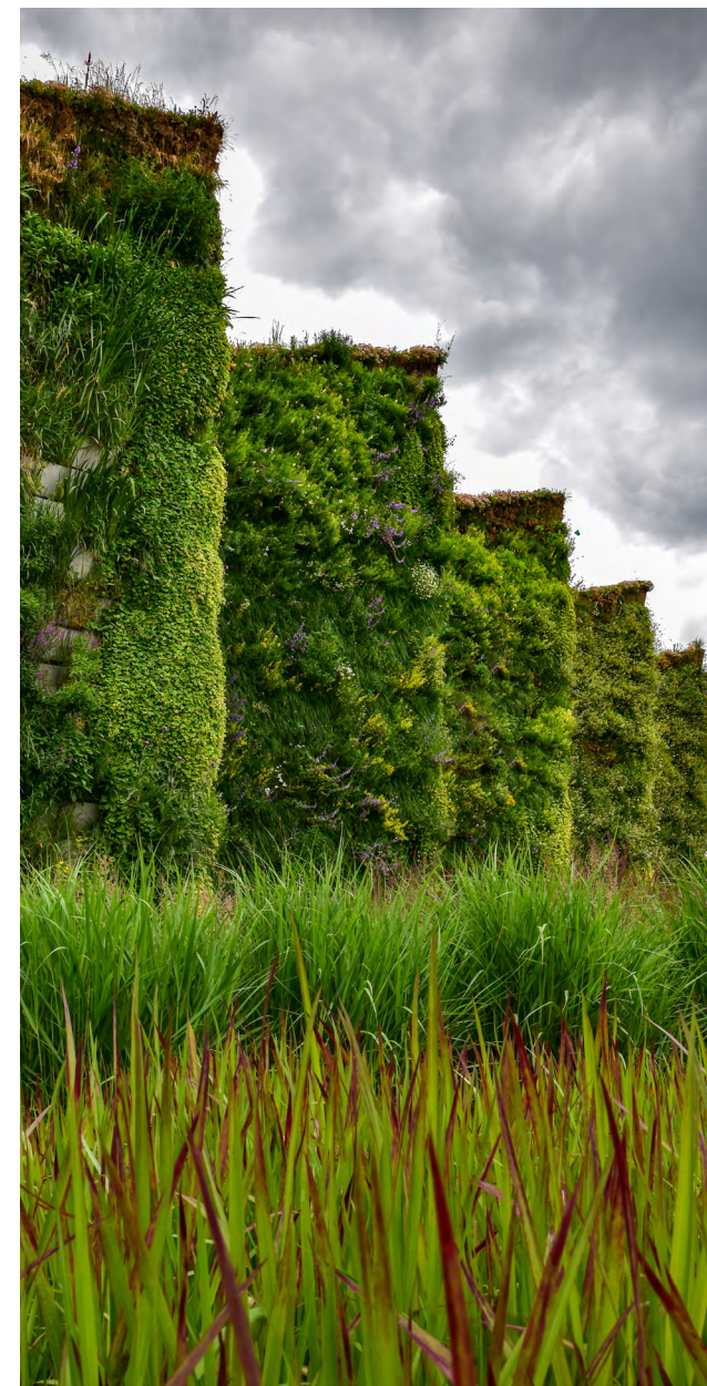
LIKO-Vo ve Slavkově u Brna - kořenová čistírna odpadních vod na průmyslové hale. V ní je odpadní voda je po přečištění využita k závlaze. (Zdroj: Liko-S)
