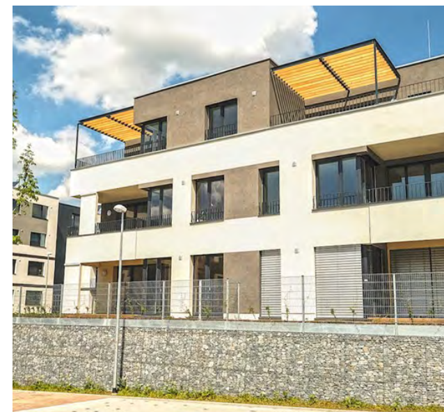
Bytové viladomy Elča a Emča projektu U cukrovaru - stínění oken napomáhají nejen vnější žaluzie, ale i markýzy či lodžie (Zdroj: Skanska Reality)
