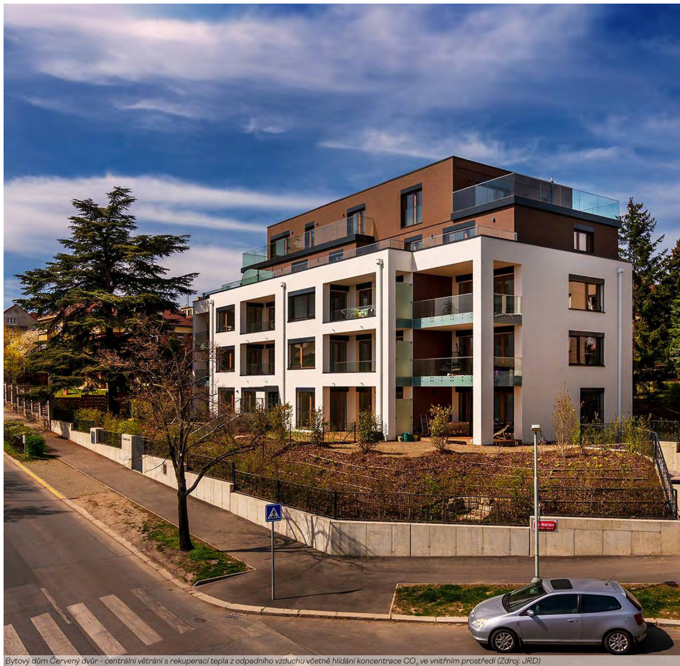
Bytový dům Červený dvůr - centrální větrání s rekuperací tepla z odpadního vzduchu včetně hlídání koncentrace CO 2 ve vnitřním prostředí (Zdroj: JRD)
