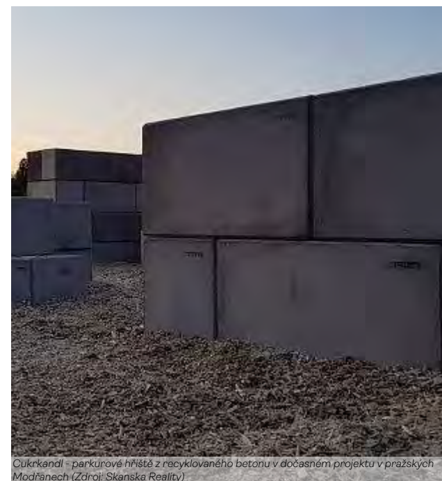
Rezidence Čertův vršek, Praha - První projekt v Čechách, kde byl Rebetong využit částečně na příčky a základové konstrukce (Zdroj: Skanska Realty)
