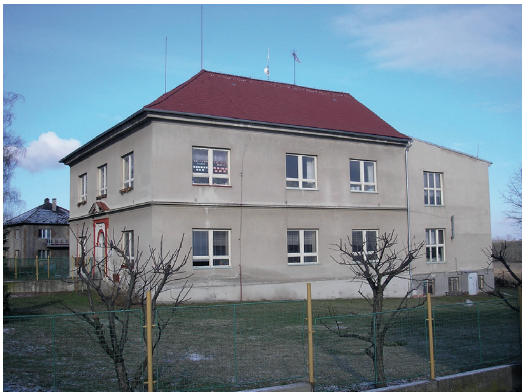
Stav před realizací
