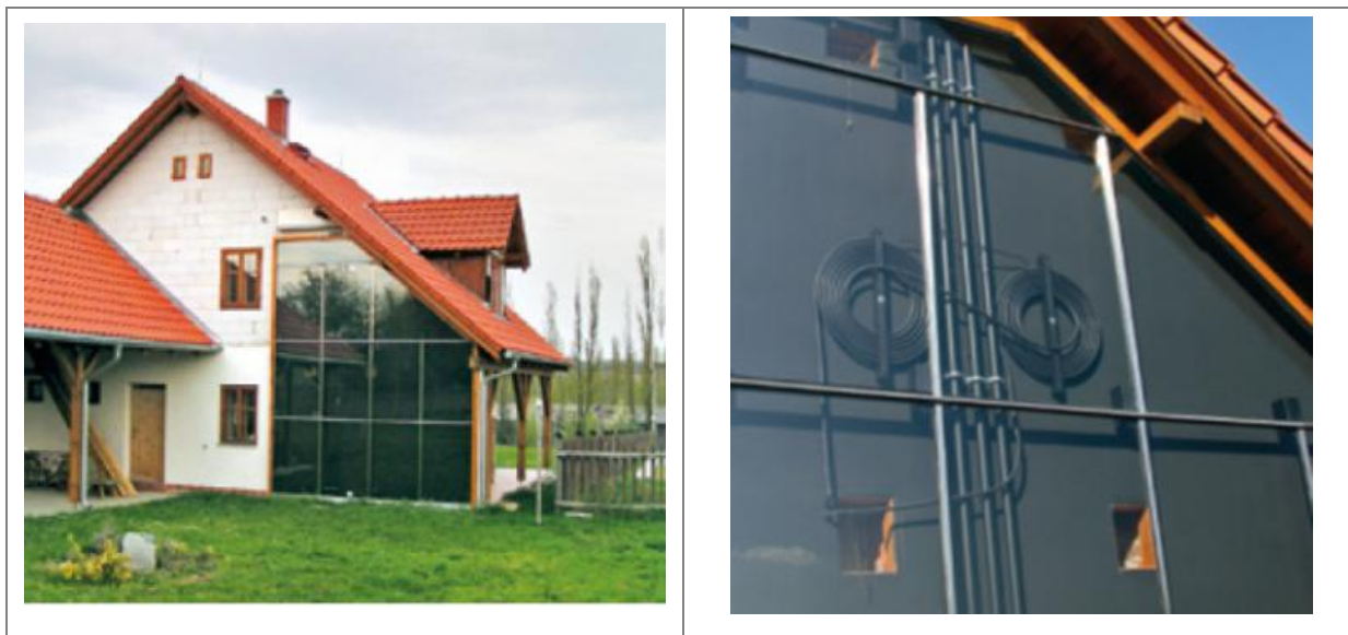
OBRÁZEK 2-9 PŘÍKLAD UŽITÍ TROMBEHO STĚNY V ČESKÝCH PODMÍNKÁCH DOPLNĚNÝ PŘÍPRAVOU TV
