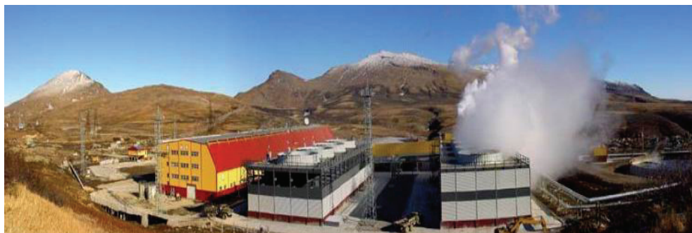
Obr. 5.12: Mutnovsky geotermální elektrárna [5]
