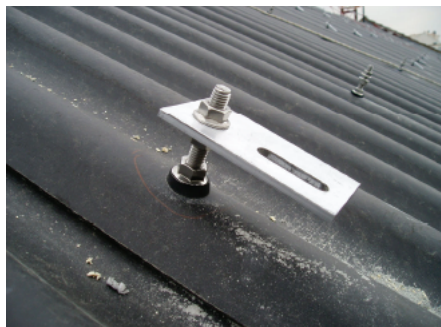
Obr. 3.20: Možné varianty uchycení panelů na sedlové střeše [15], [2]
