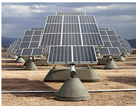
Obr. 3.22: Polohovatelný systém pro uložení panelů [15]
