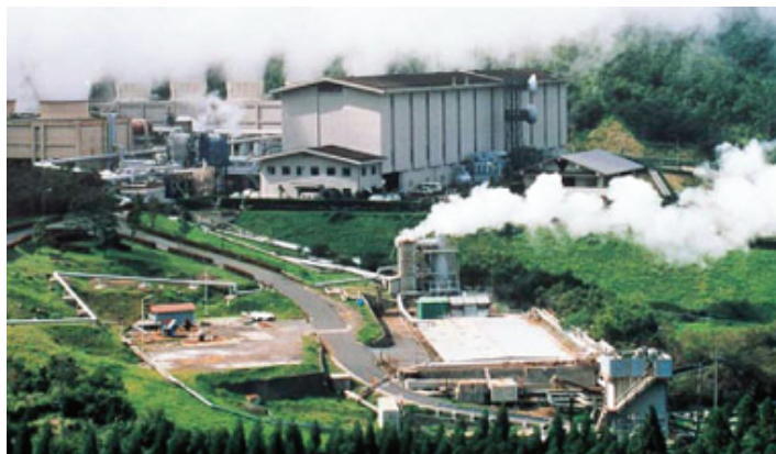
Obr. 5.13: První elektrárna na principu „double flash“ [6]
