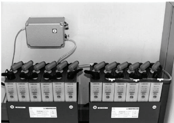
Obr. 10.19: Olověné akumulátory v reálné aplikaci [10]
