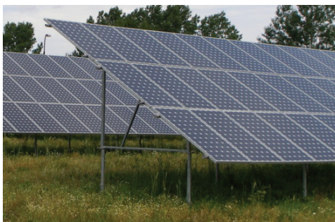
Obr. 3.21: Uchycení panelů na ploché střeše a volném prostranství [15], [2]
