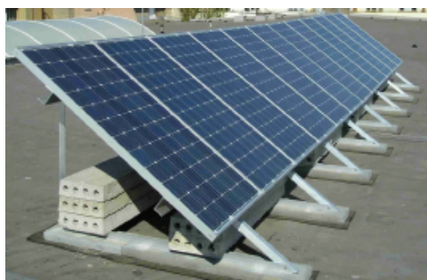
Obr. 3.21: Uchycení panelů na ploché střeše a volném prostranství [15], [2]
