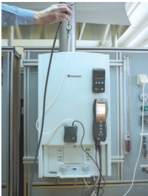
Obr. 1 – Uspořádání přístrojů pro současné měření spalin a tahu (2 měřicí otvory v kouřovodu)
