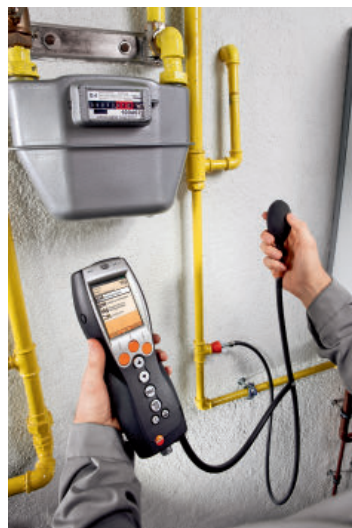
Obr. 3 – Kontrola plynového potrubí přístrojem testo 330 LL
