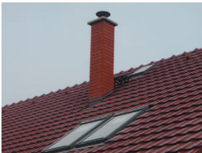
Obr. 2 – Nadstřešní část komínu HELUZ s prstenci GRAND v cihlové barvě
