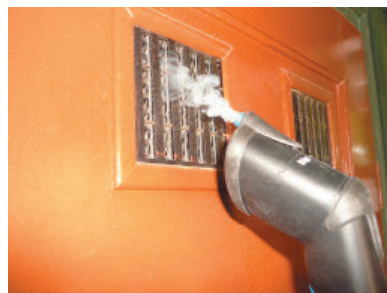
Obr. 1 – Ukázka měření proudění vzduchu u větrací mřížky, které ukazuje, že otvory namísto přivádění vzduchu, vzduch odsávají
