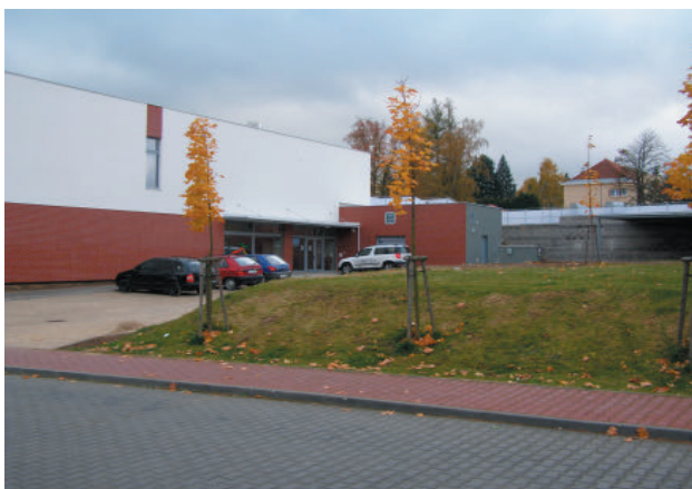
Obr. 1 – Víceúčelový objekt v Humpolci
