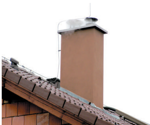
Obr. 4 – Dvoupřáduchový komín HELUZ KLASIK s kloboukem a HELUZ PLYN s hlavicí odkouření
