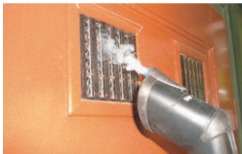
Ukázka použití zařízení v praxi k ověření zda uvedený větrací otvor vzduch přivádí nebo odvádí
