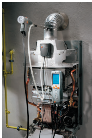
Obr. 4 – Měření se sondou jemného tlaku
