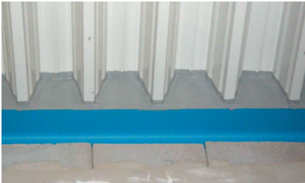
Příklad těsnění spáry u trapézového plechu
