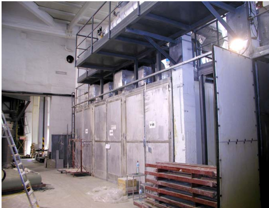
Vnější pohled na zavážecí vrata sušáren
