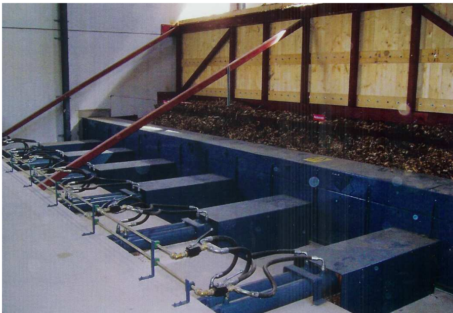
Pohled na upevnění hydraulických válců
