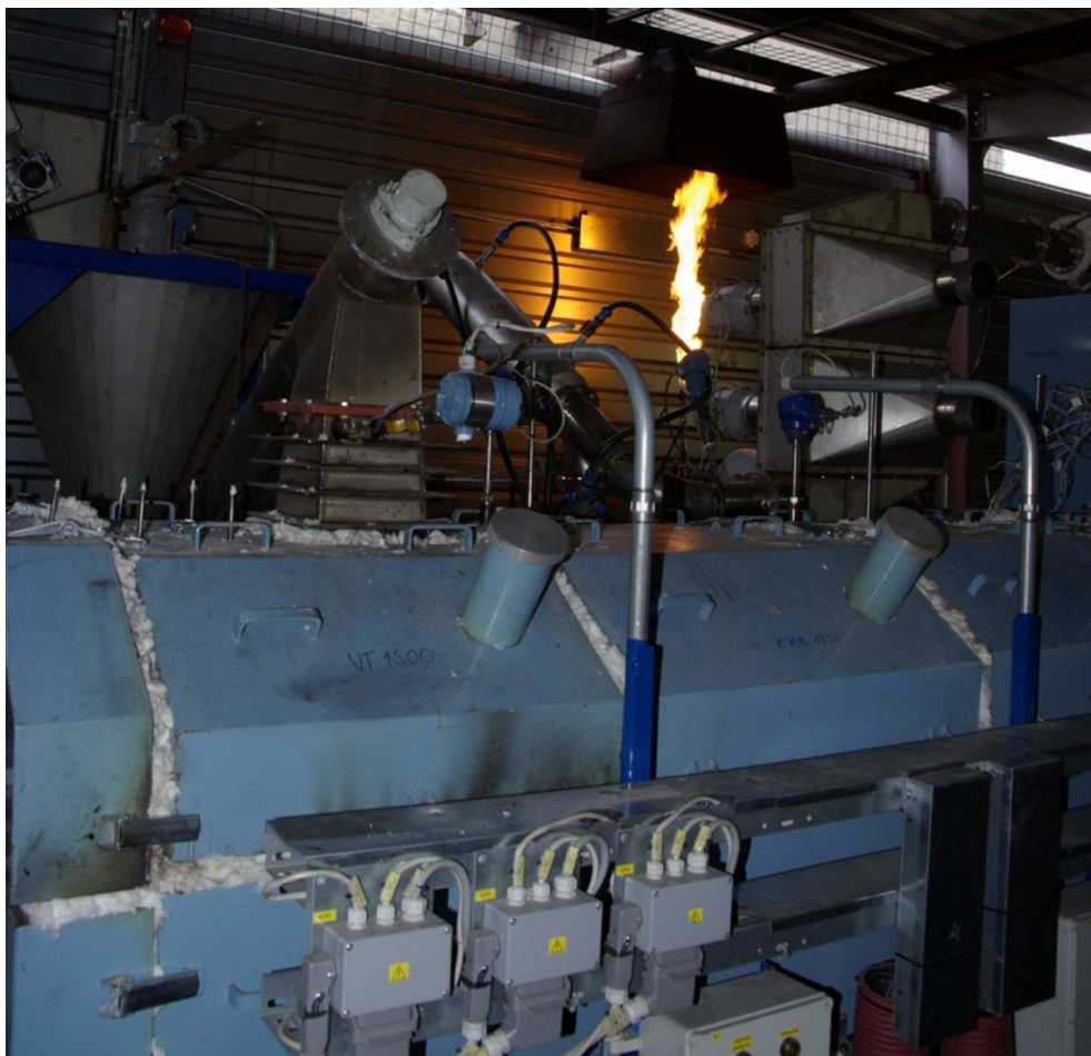
Poloprovozní jednotka PYROMATIC
