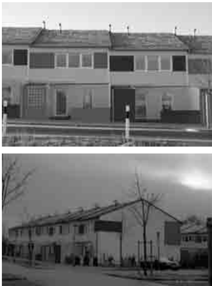
Obr. 7: Pasivní dům za chladného jasného dne a za zamračeného mírně chladného dne.
