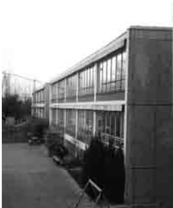
Obr. 1 Pohled z jižní strany před sanací
