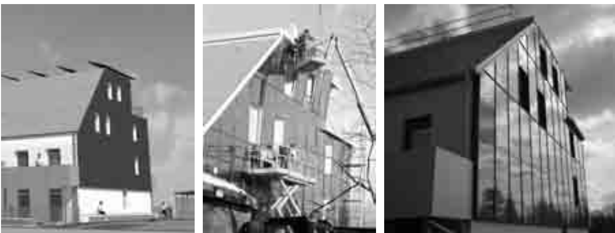
Abb. 10 Montage des Warmwasserkollektors
