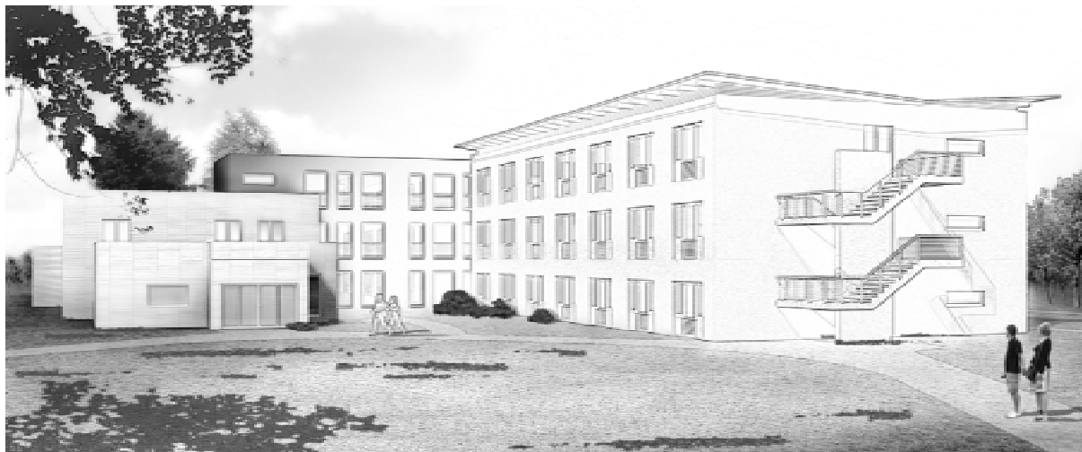
Charitní dům sv. Josefa, první velká stavba z prefabrikovaných železobetonových modulů ve standardu pasivního domu na světě
