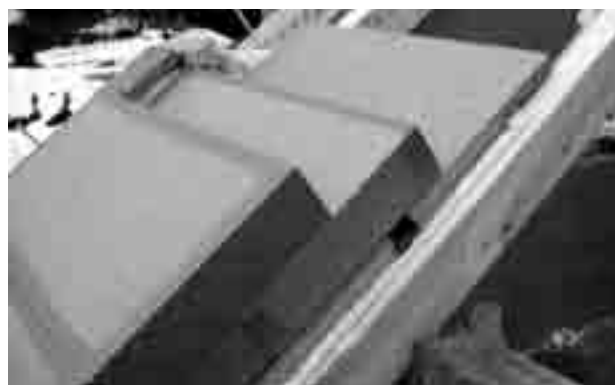
Obr. 5 Nadkroevní systém TopTherm Rigips
