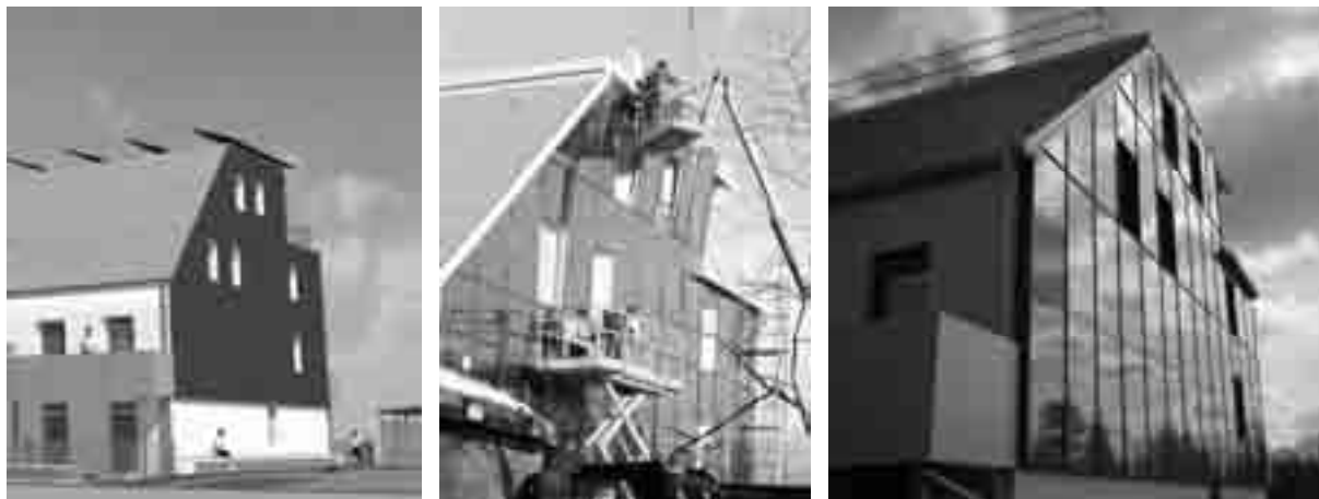
Obr. 10 Montáž kolektoru na teplou vodu
