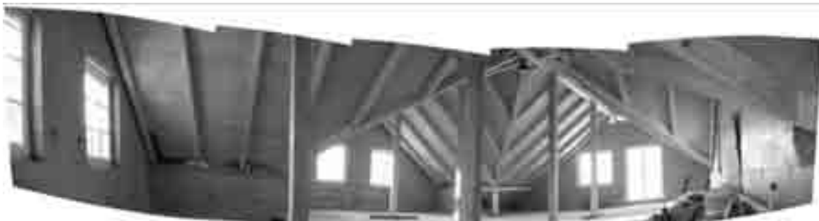
Obr. 6 Panorama podkroví z desek Rigidur a hoblovaného krovu má zvláštní atmosféru
