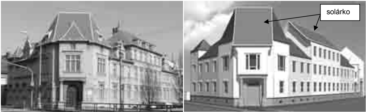
Obr. 3 Umístění solárního systému
