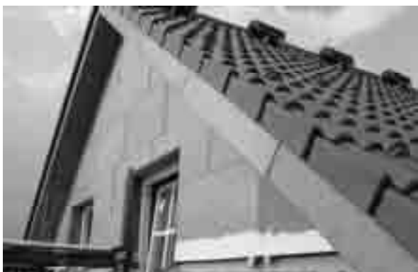
Obr. 4 Těžká stěna tl. 420mm, R=8,2m2
