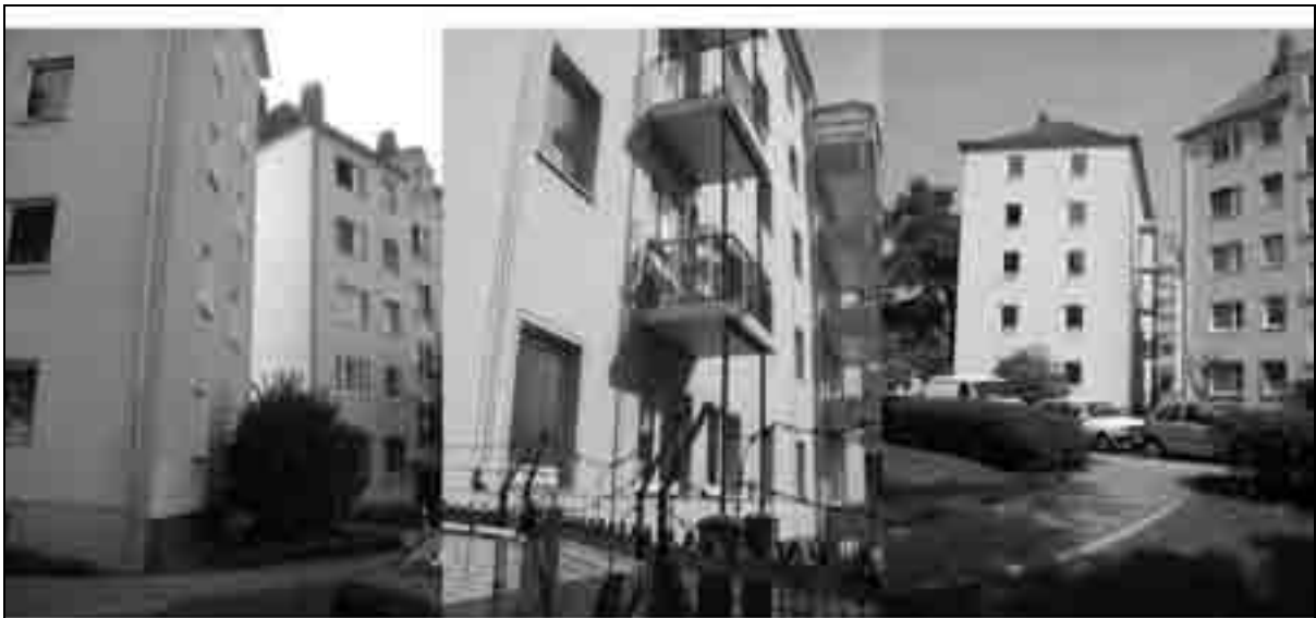
Abbildung 1: Außenansicht des Gebäudes vor der Modernisierung [Lindener Baukontor]
