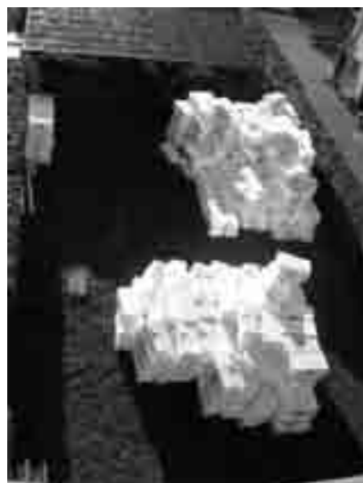
Obr. 8 Dodání tepelné izolace
