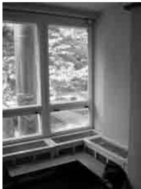
Abb. 2 Detail- Ansicht vor der Sanierung
