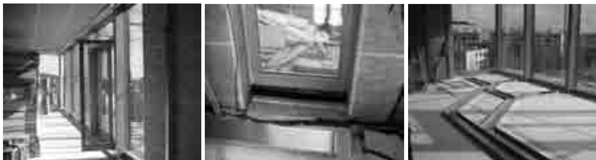
Obr. 4 Okna s trojitým převážně pevným zasklením. Podhled stropu vyplněný tepenou izolací.
