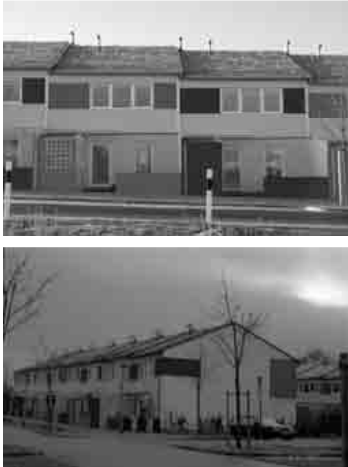
Abb. 3: Passivhaus an einem kalten, klaren und an einem trüben, mäßig kalten Tag.
