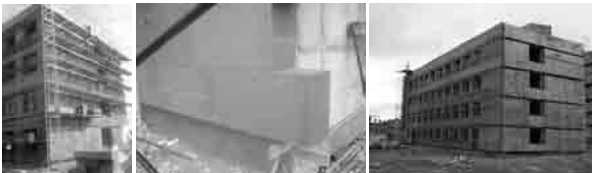
Obr. 7, 8, 9: Zateplení vnější stěny, Neopor cca 320 mm
