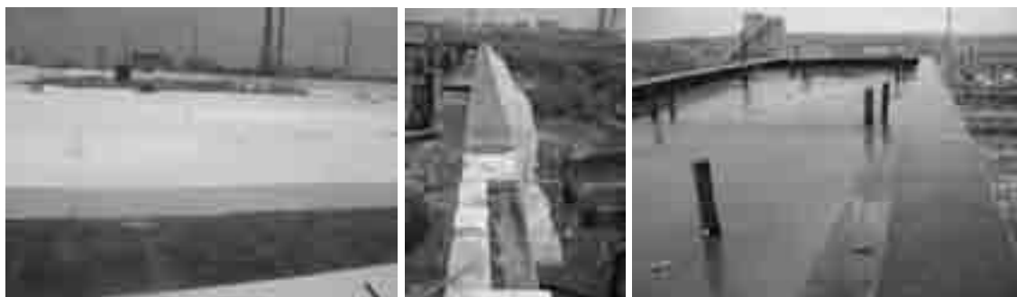
Obr. 10, 11, 12: Zateplení střechy, polystyrén cca 450 mm
