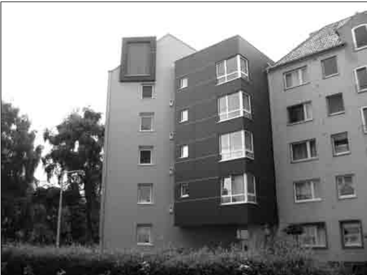
Abbildung 2: Außenansicht des Gebäudes nach der Modernisierung [Lindener Baukontor]
