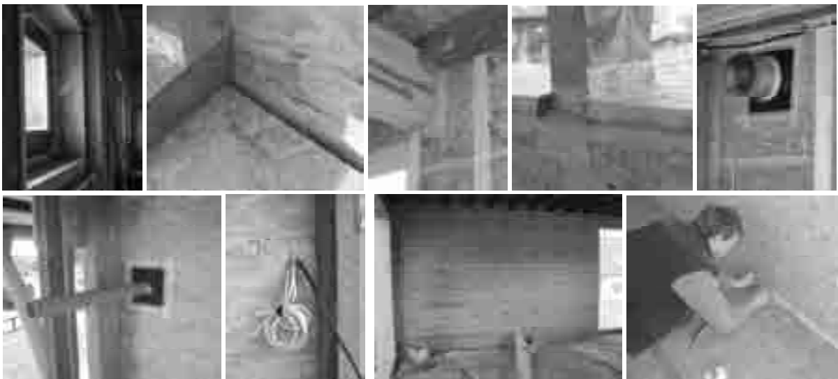
Obr. 5 Detaily zajištění těsnosti vzduchotěsné a parotěsné vrstvy.
