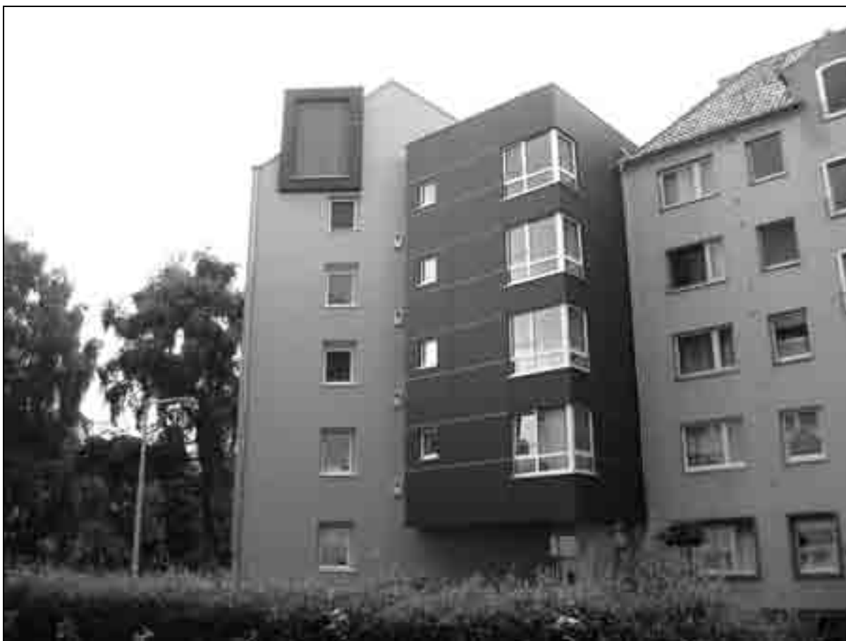
Obr. 2: Pohled na budovu po modernizaci [Lindener Baukontor]
