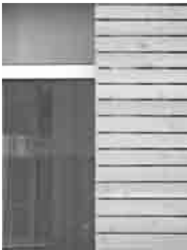
Kompozice materiálů na fasádě ze skla, šedě lazurovaných modřínových panelů a modřínového obložení
