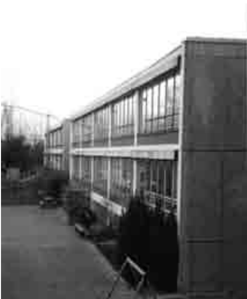
Abb. 1 Ansicht Südseite vor der Sanierung
