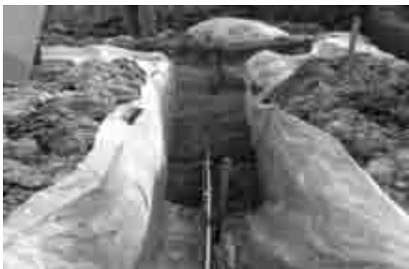
Obr. 2 Integrované chlazení v základech
