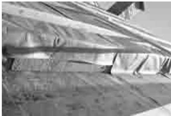
Bild 4: Aufdachdämmung 20 cm
