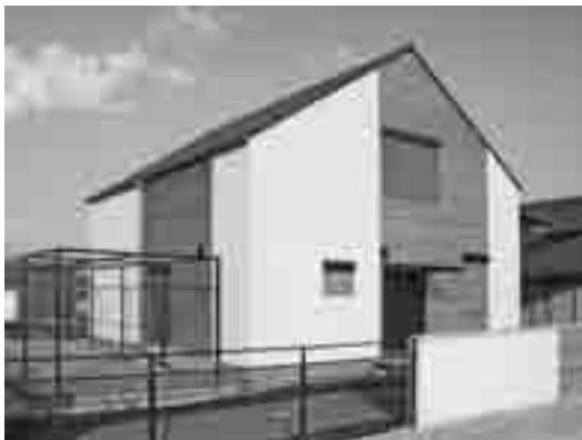
Obr. 8 Pohľad zo severovýchodu
