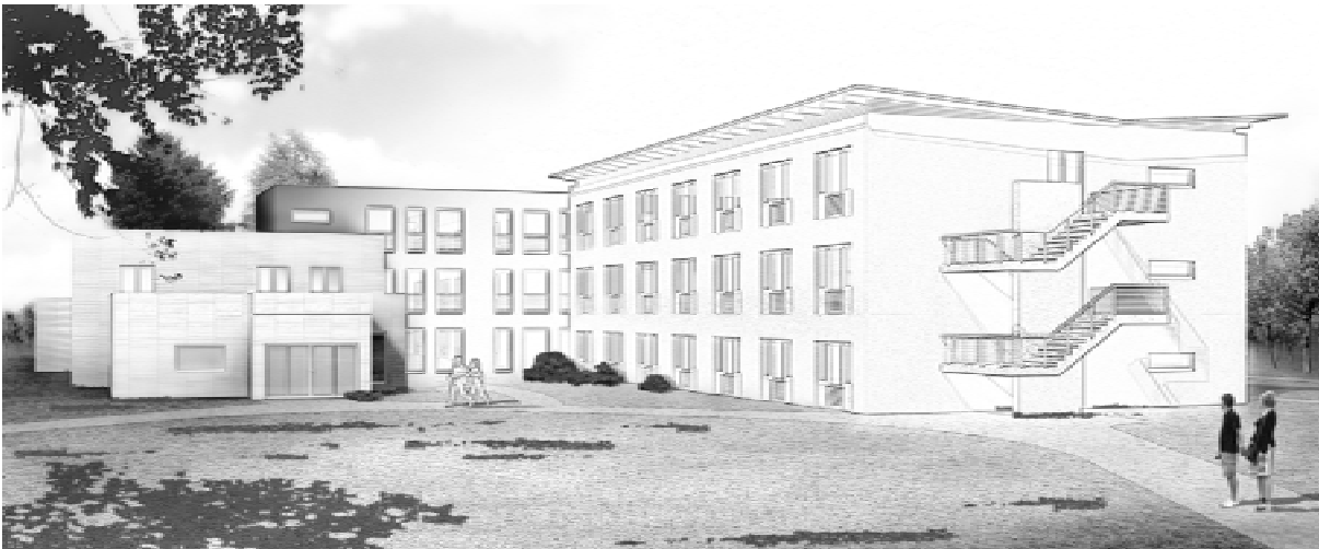
Caritas-Haus St. Josef, weltweit erster Großbau in vorgefertigter Stahlzellen-Modulbauweise als Passivhaus
