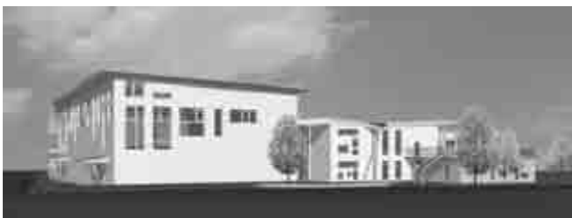
Obr. 1 Celkový pohled severní
