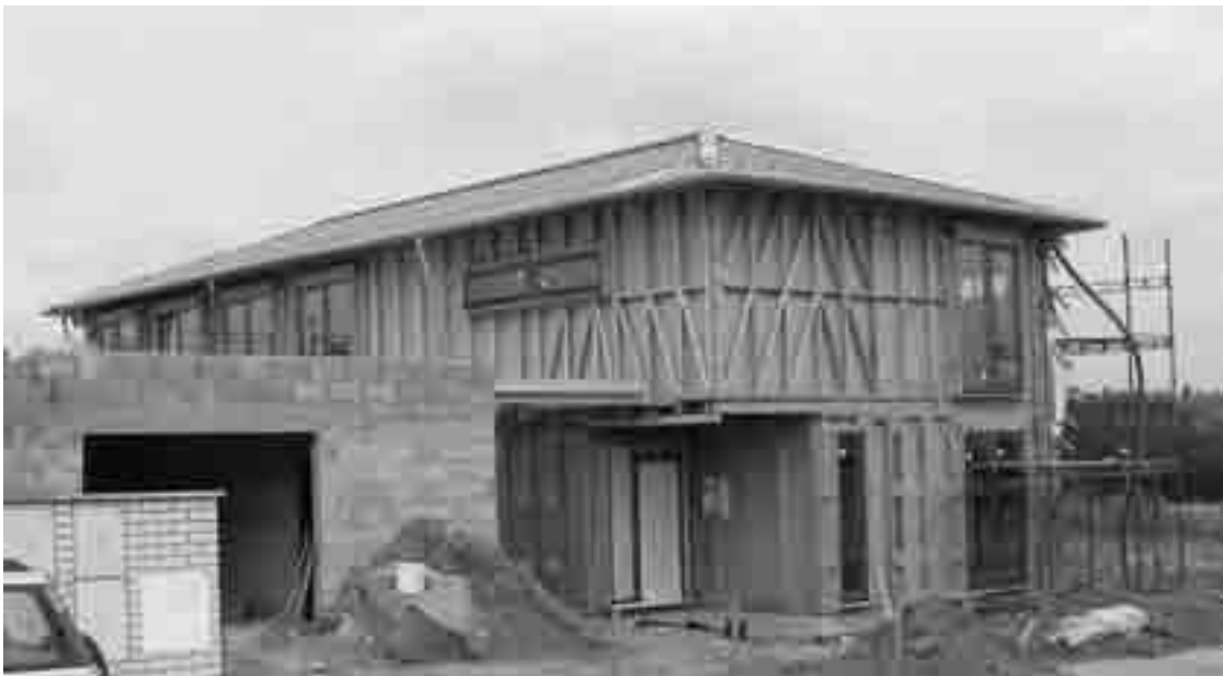
Obr. 2 Objekt ve fázi realizace. Stav k 08/2008.
