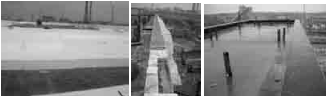
Abbildung 8, 9 und 10: Dach Wärmedämmung aus Polystyrol ca. 450 mm
