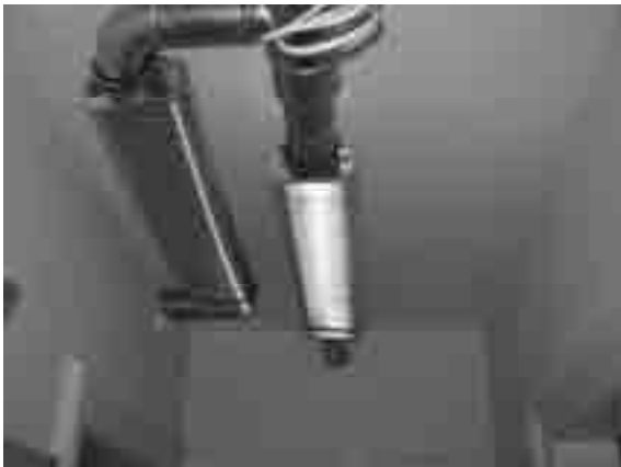
Bild 7 Telefonie-Schalldämpfer im Flur zur Wohnungseinheit
