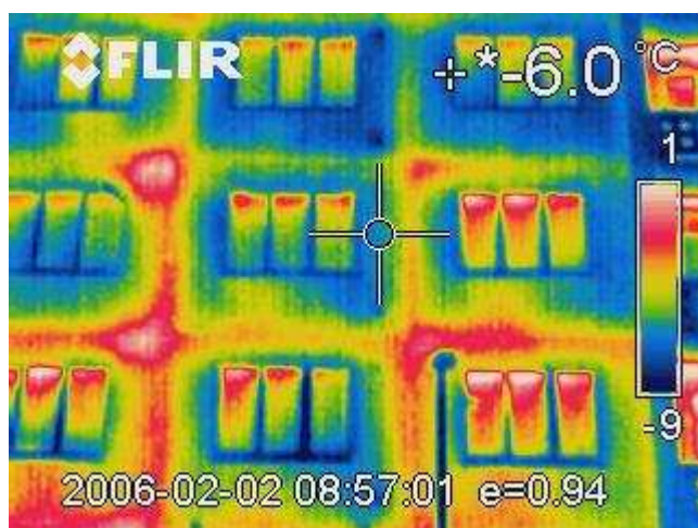
Obrázek 7: Termovizní snímek nezatepleného bytového objektu postaveného panelovou technologií v 60. letech 20. století
