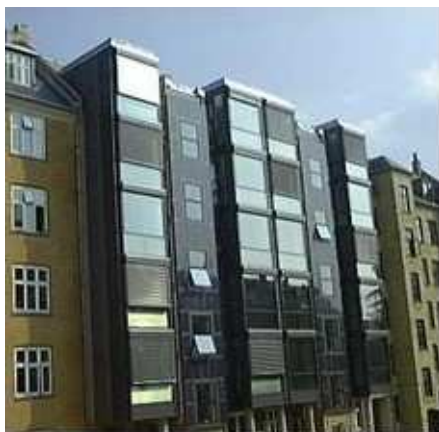
Obrázek 23: Pohled z ulice na fasádu s integrovanými fotovoltaickými články
