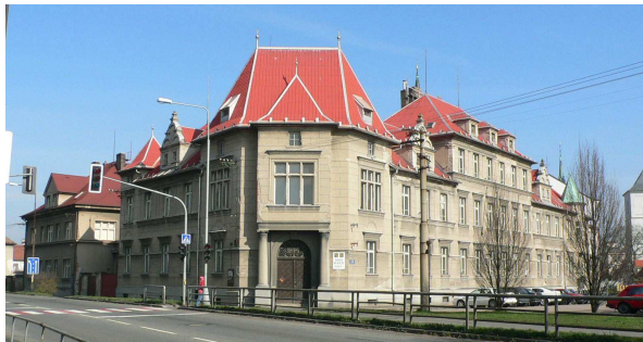
Obrázek 15: Vysoké Mýto – stav před rekonstrukcí
