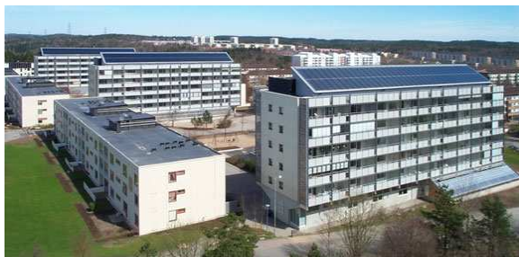
Obrázek 20: Gårdsten – solární panely zajišťují ohřev teplé vody
