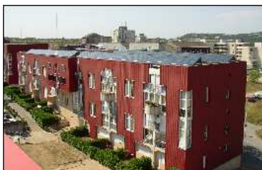
Obrázek 39: Vzhled bytového domu po rekonstrukci
