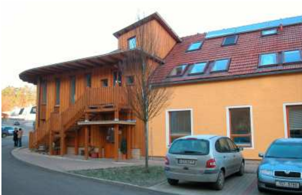
Obrázek 14: Napojení původní a nové části distribučního skladu – na střeše jsou instalovány solární kolektory zajišťující ohřev teplé vody
