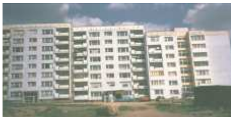
Obrázek 42: Vzhled bytového domu před rekonstrukcí
