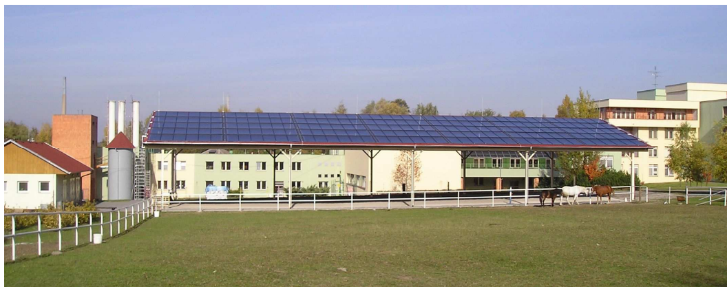
Obrázek 12: Solární ohřev teplé vody je instalován na střeše přístavku
