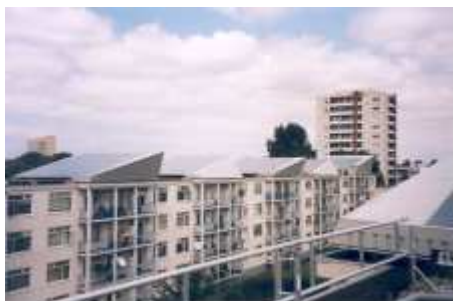
Obrázek 31: Pohled na střechy bytových domů – solární kolektory na teplou vodu
