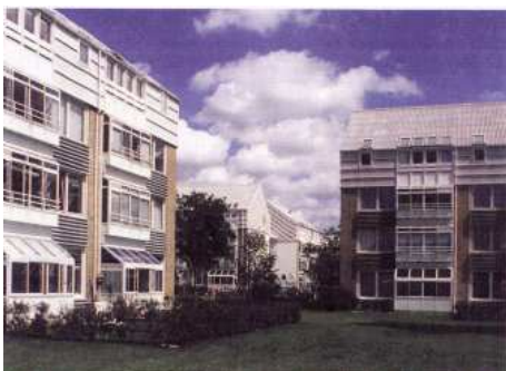
Obrázek 25: Realizace střešních nástaveb a rekonstrukce stávajících podlaží
