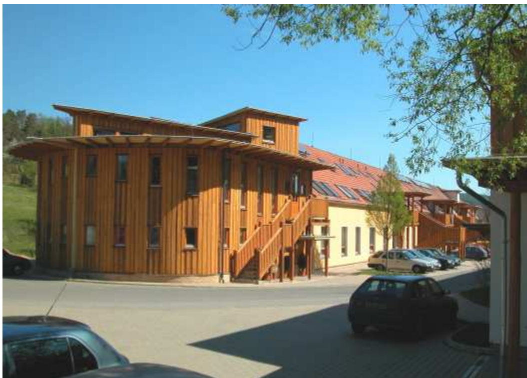
Obrázek 13: Pohled na novou a stávající část objektu
