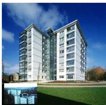
Obrázek 36: Vzhled bytového domu po rekonstrukci
