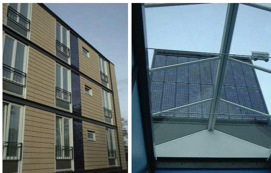
Obrázek 24: Osazení fotovoltaických článků na komín, průčelní a štítovou stěnu budovy
