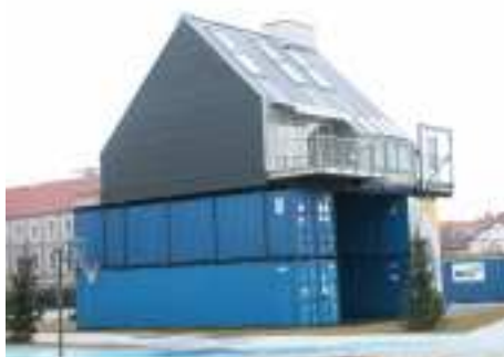
Obrázek 26: Využití prostorové prefabrikace při obnově – PROTOTYP STŘEŠNÍ NÁSTAVBY
