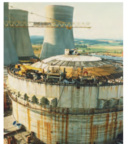
DOKONČOVACÍ PRÁCE NA OCHRANNÉ OBÁLCE A KOPULI REAKTORU | FINISHING WORKS ON THE PROTECTIVE ENVELOPE AND THE REACTOR CAP
