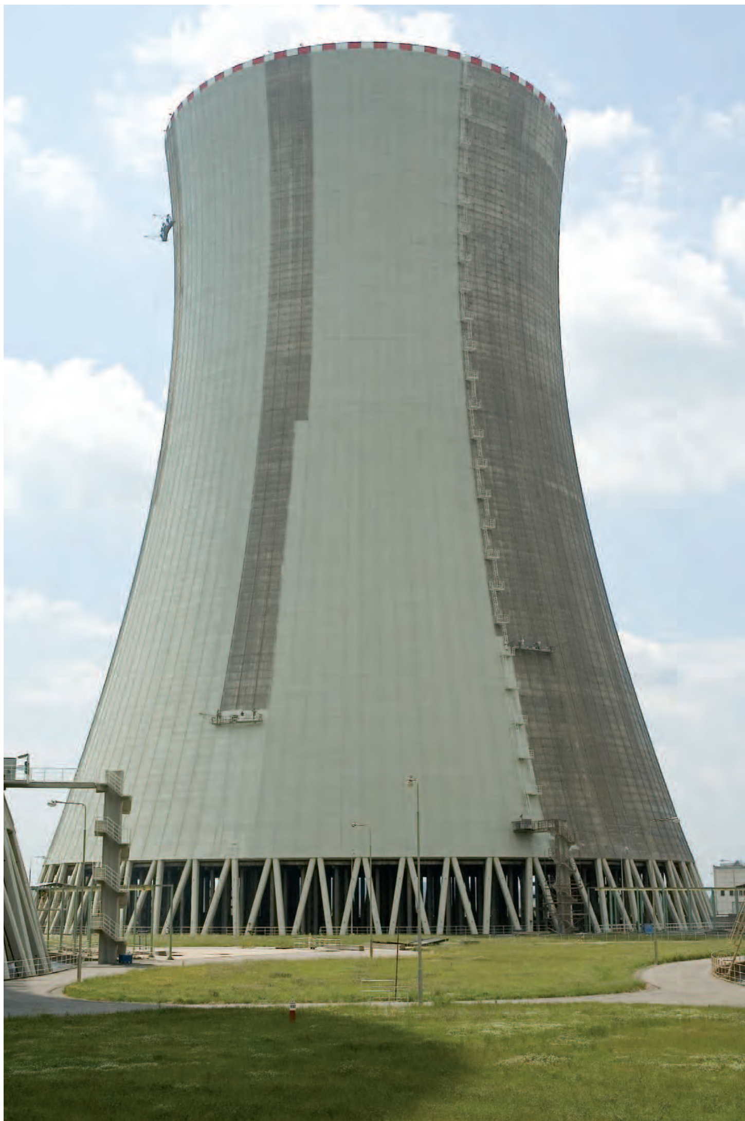
OCHRANA NÁTĚREM VNĚJŠÍHO PLÁŠTĚ CHLADICÍ VĚŽE PROTECTIVE PAINT OF THE EXTERNAL COATING OF THE COOLING TOWER
