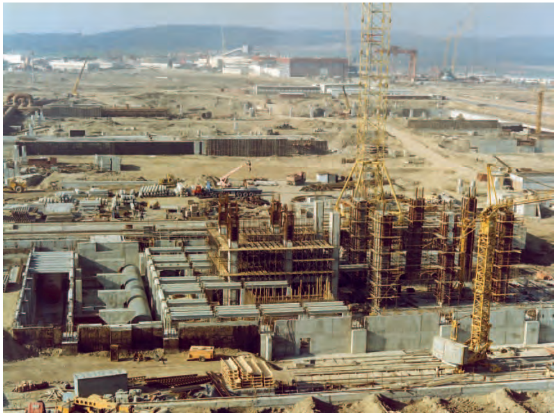
POHLED NA STAVENIŠTĚ ELEKTRÁRNY | POWER PLANT CONSTRUCTION SITE
