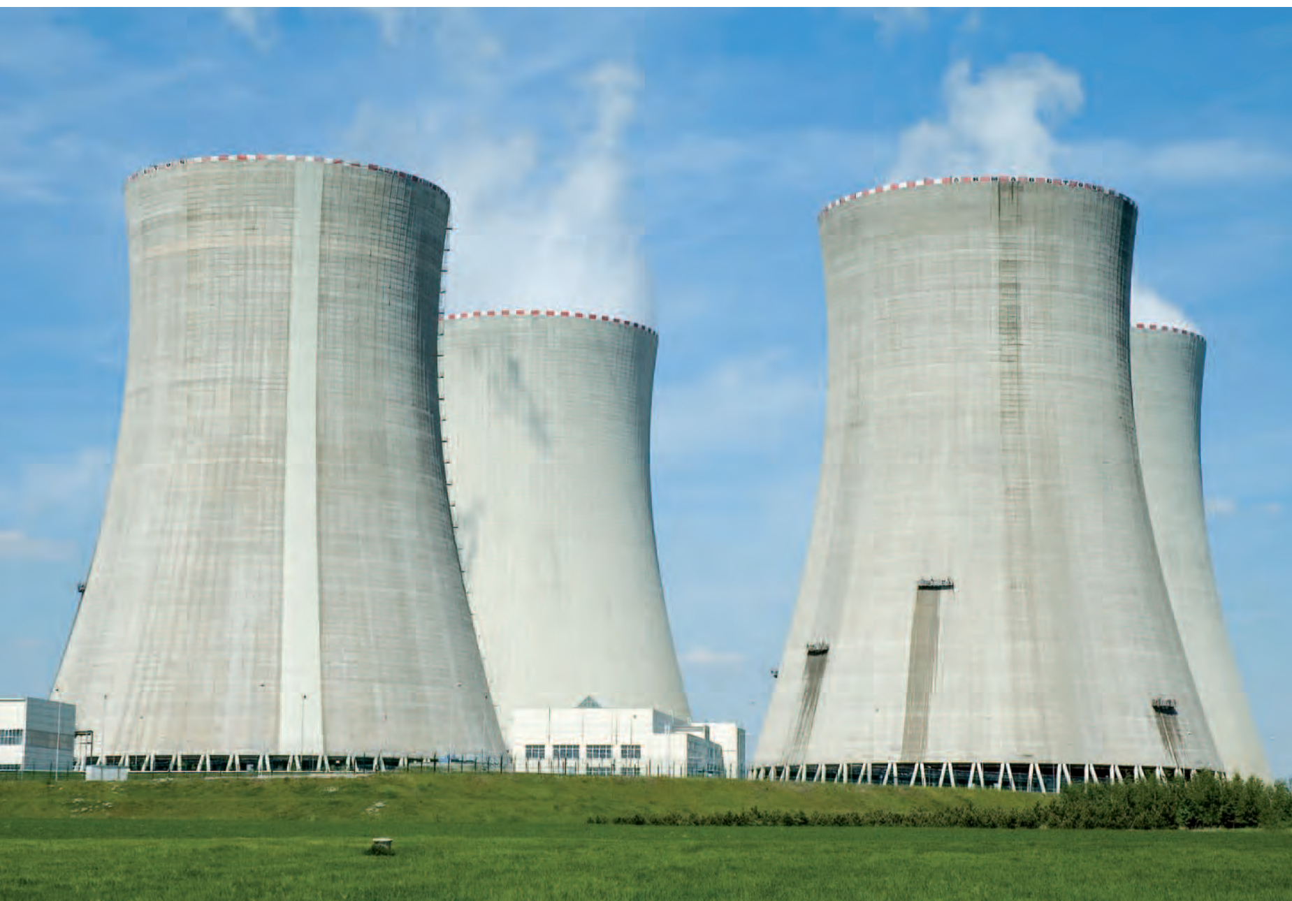
CHLADICÍ VĚŽE COOLING TOWERS
