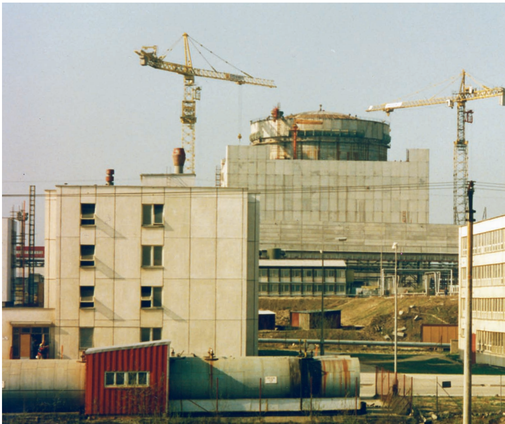
V POPŘEDÍ ŠATNY ZAŘÍZENÍ STAVENIŠTĚ, V POZADÍ OCHRANNÁ OBÁLKA REAKTORU IN THE FRONT THE DRESSING ROOMS OF THE CONSTRUCTION FACILITY, IN THE BACK THE PROTECTIVE ENVELOPE OF THE REACTOR
