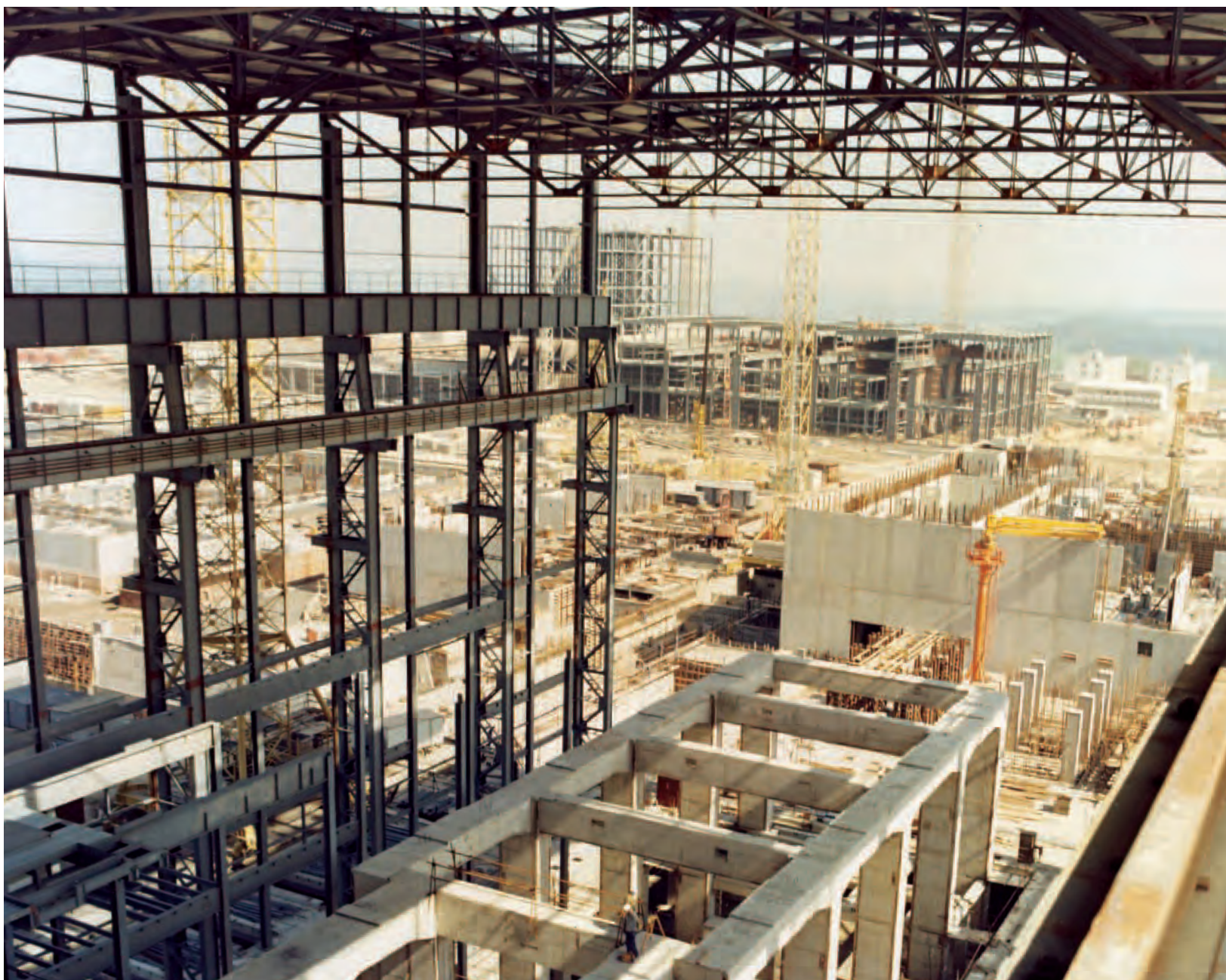
VNITŘNÍ ČÁST STROJOVNY SE ZÁKLADY TURBOGENERÁTORU A NAPOJENÍ NA BUDOVU REAKTORU
