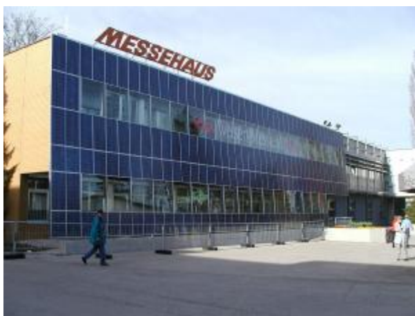
Obrázek 18: Budova s fotovoltaickou fasádou (Wels, Rakousko)
