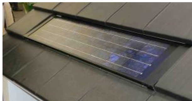
Obrázek 15: Fotovoltaické panely mohou tvořit i střešní krytinu.
