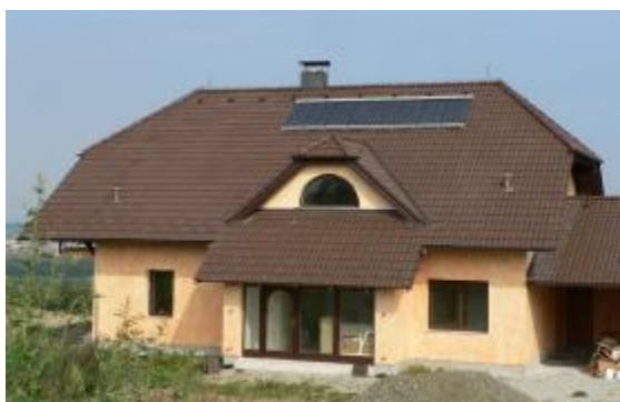
Obrázek 9: Kolektor integrovaný do střechy a uložený nad střešní krytinou
