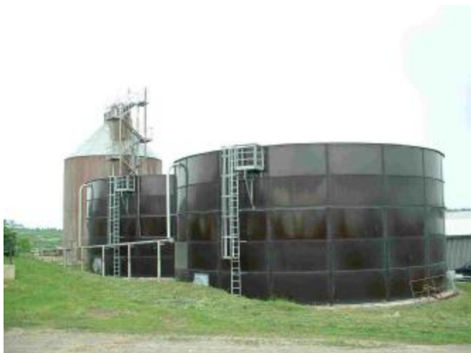
Obrázek 46.:Kontinuální systém na zpracování kejdy v Dánsku.
