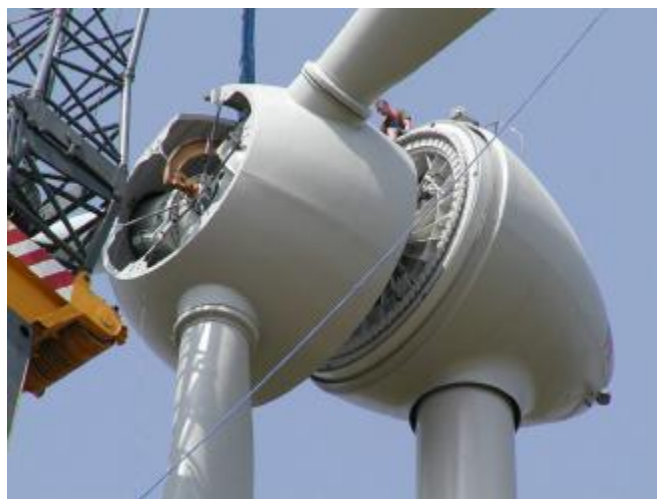
Obrázek 37: Montáž rotoru 600 kW v Jeseníkách
