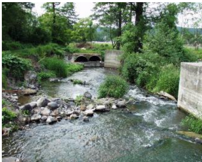
Obrázek 30: Tlakový přivaděč před rekonstrukcí.
