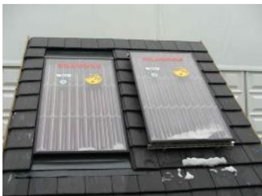
Obrázek 9: Kolektor integrovaný do střechy a uložený nad střešní krytinou
