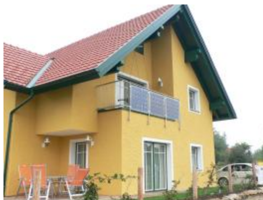
Obrázek 21: Fotovoltaické panely na zábradlí balkonu
