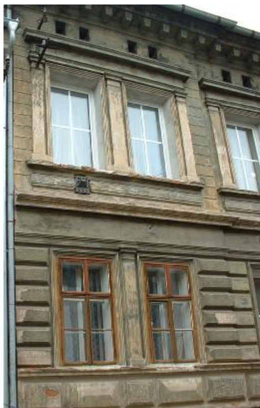
Obrázek 13: Esteticky i funkčně pochybná výměna okna
