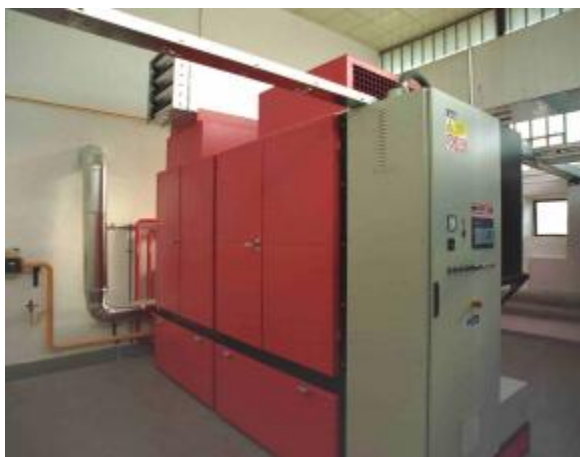
Obrázek 6: Kogenerační jednotka na ČOV Česká Lípa, výkon 125 kWe, palivo bioplyn Obrázek 7: Kogenerační jednotka na ČOV Brno, výkon 2x 520 kWe, palivo bioplyn + zemní plyn
