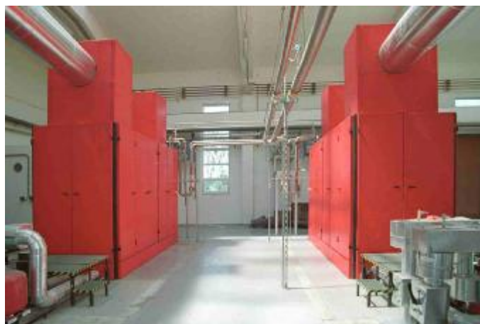
Obrázek 6: Kogenerační jednotka na ČOV Česká Lípa, výkon 125 kWe, palivo bioplyn Obrázek 7: Kogenerační jednotka na ČOV Brno, výkon 2x 520 kWe, palivo bioplyn + zemní plyn
