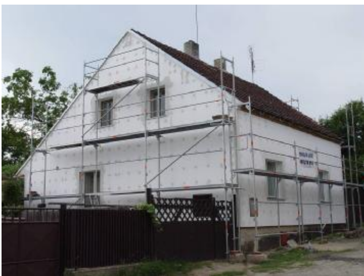
Obrázek 15: Zateplení domku vyřeší i potřebu nové fasády.
