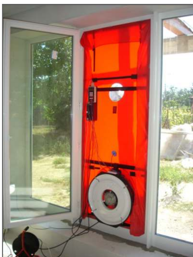
Obr.5 Meranie vzduchovej priepustnosti tzv. BlowerDoor test
