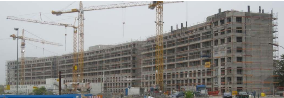
Abbildung 1 Baumaßnahme Südansicht Rohbau
