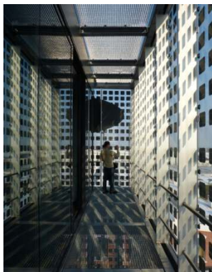
Obr. 6 Prostor mezi plášti fasády
