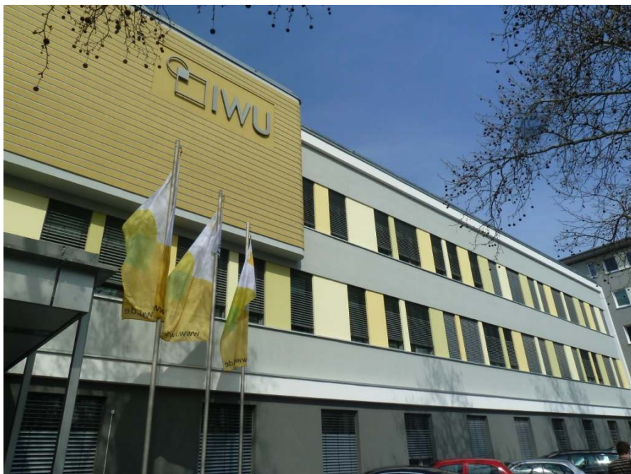
Obrázek 1 Dům IWU prošel kompletní modernizací pomocí komponentů v pasivním standardu, atraktivní projekt navrhli zkušební architekti.
