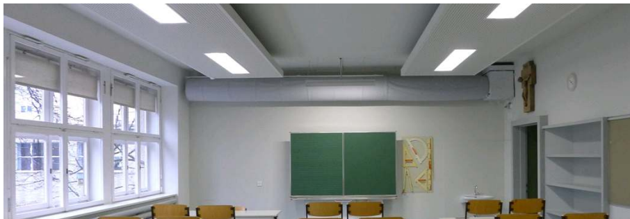
Obrázek 1: Prototyp větracího boxu s tlumící komorou, který vyrobila ATREA
