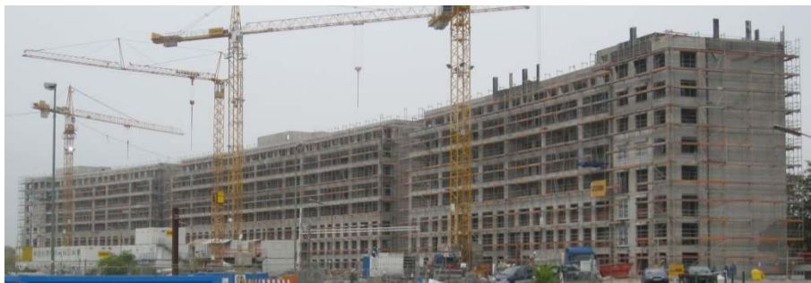
Obrázek 1 Stavební projekt – jižní pohled na hrubou stavbu
