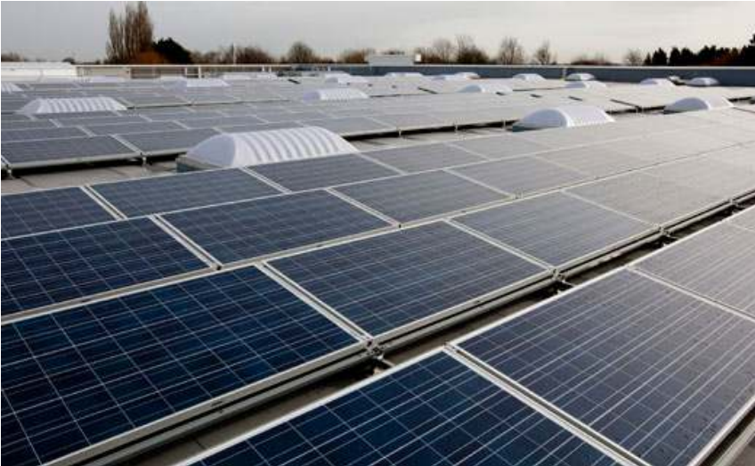
Abbildung 6 ) Nutzung von gemeinsamen Unterkonstruktionen Tageslicht und Photovoltaik
