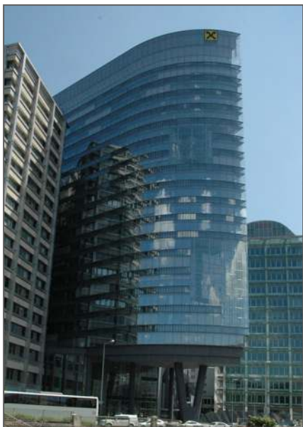
Obr. 1 Prístavba budovy Reifeisenbank vo Viedni je prvá certifikovaná výšková budova v pasívnom štandarde.
