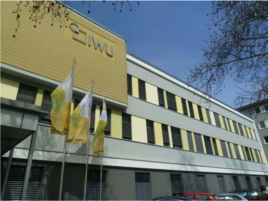
Abbildung 1 Das IWU-Haus wurde von den erfahrenen Architekten mit passivhaustauglichen Komponenten umfassend modernisiert und attraktiv gestaltet.
