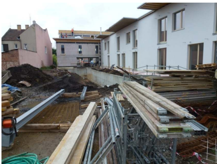
Obr. 2 Celkový pohled na bytovou část a provozní objekt při kolaudaci.
