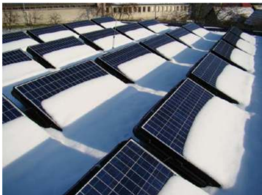
Obr. 10 Výkon fotovoltických panelov na plochej streche objektu znižovala snehová pokrývka...
