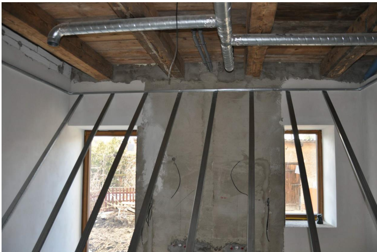
Obrázek 27 Provedení VZT je obvykle možné i při renovacích, pokud je k dispozici dostatečná výška stropů (zdroj: PORSENNA o.p.s.)
