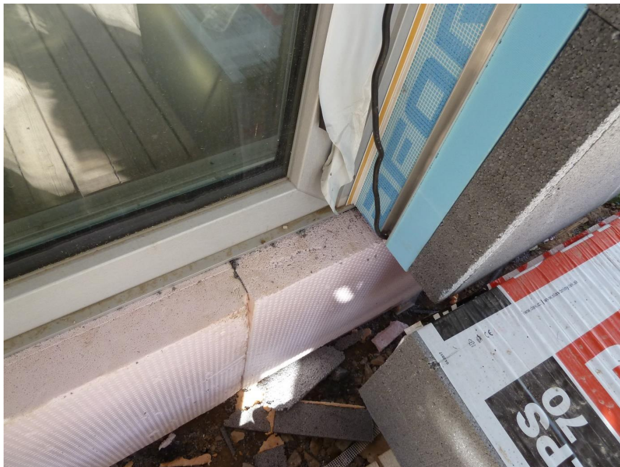
Obrázek 9 Detail izolace rámu okna za pomoci izolované kolejnice vnějšího stínění (zdroj: PORSENNA o.p.s.)
