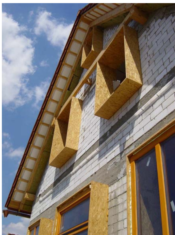
Obr. Do předsazeného roštu z latí kotvených do kříže (na obrázku) nebo I-nosníků se pak vkládá měkká izolace. Další vrstvy, např. odvětrávanou fasádu, je možné do těchto prvků kotvit bez vzniku tepelných mostů.
