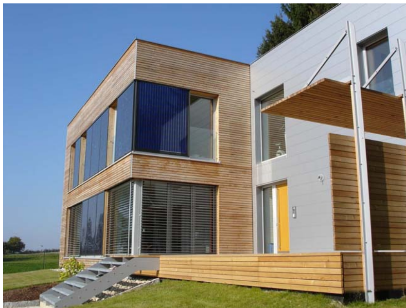
Obr Stav po rekonstrukci
