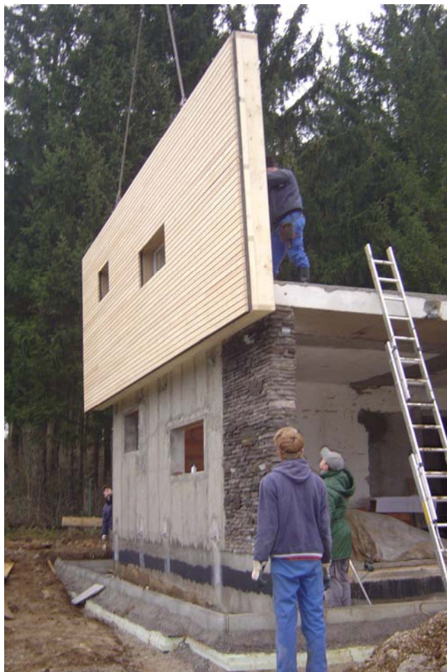
Obr. Instalace předsazené fasády
