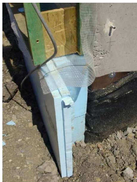
Obr. Extrudovaný polystyren se používá především tam, kde dochází ke kontaktu tepelné izolace se zeminou. Na obrázku je použití při izolaci soklu seminárního centra v Hostětíně. Pro izolaci vrchní betonové stěny byla použita minerální vlna vkládaná mezi lepené I-profilů.
