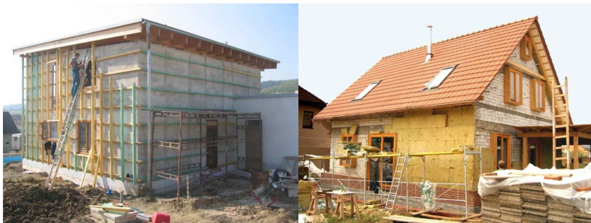
Obr. Do předsazeného roštu z latí kotvených do kříže (na obrázku) nebo I-nosníků se pak vkládá měkká izolace. Další vrstvy, např. odvětrávanou fasádu, je možné do těchto prvků kotvit bez vzniku tepelných mostů.
