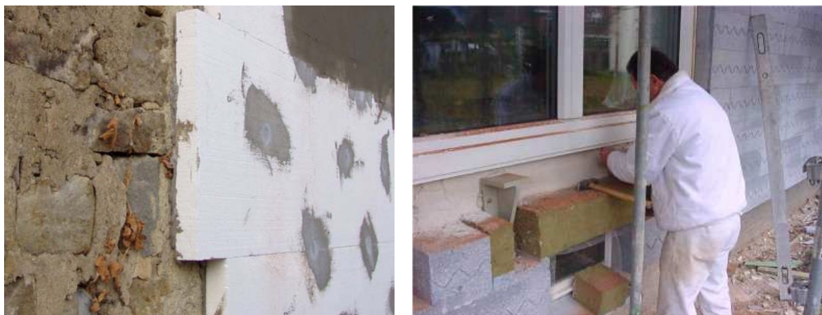
Obr. Porovnání: 5 cm polystyrenu a 20 cm polystyrenu s příměsí grafitu na druhém obrázku. Cena zateplovacího systému je jen asi o 20% vyšší, ale úspory během 30-ti letého životního cyklu jsou několikanásobné
