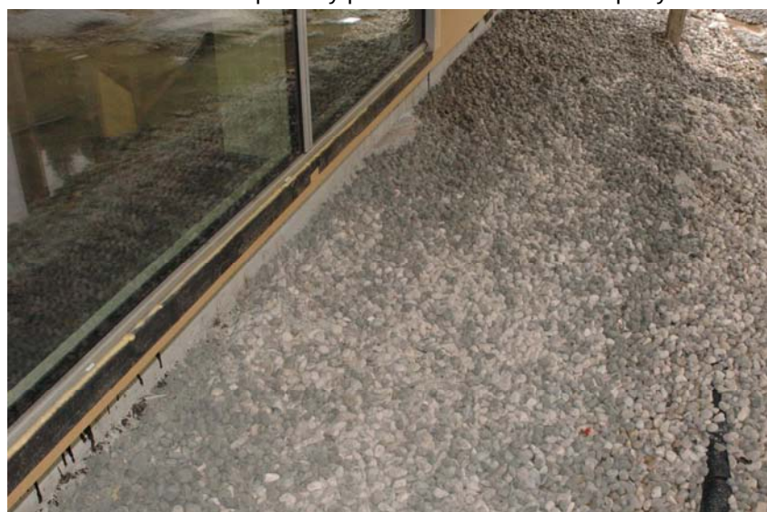
Obr. Izolace základů a podlahy pomocí štěrku ze skelné pěny
