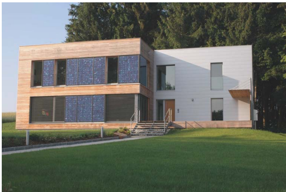
Obr. Dům po rekonstrukci. Fasáda s instalovanými fotovoltaickými články.
