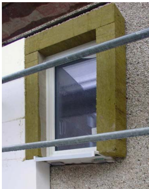
Obr. Výhodou izolace z minerálních vláken je její nehořlavost. Zde při sanaci mateřské školy v Drážďanech na úroveň pasivního standardu bylo vytvořeno nehořlavé ostění okna. Minerální vlna se často používá v kombinaci s polystyrenem.
