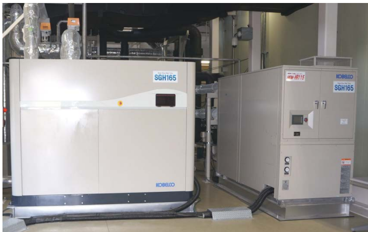
Obrázek 8: Model TČ SGH 165 s dodávkou tepla v podobě páry; vpravo tepelné čerpadlo, vlevo parní kompresor (Zdroj: Kobelco Ltd.)
