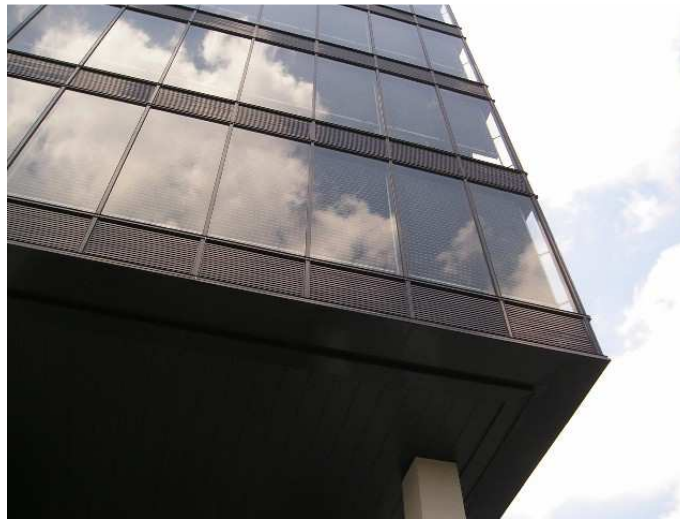
Obr. 7.34 Pohled na dvojitou fasádu budovy AB Reding v Bratislavě
