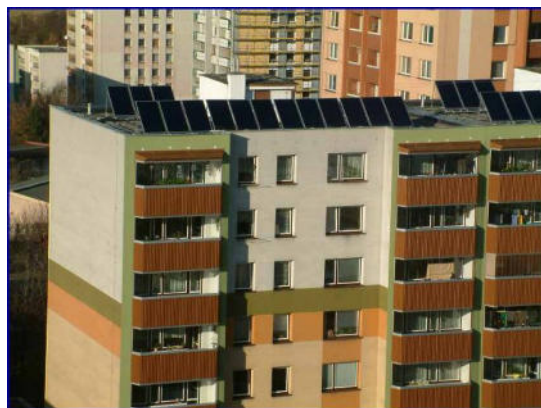
Obrázek 35: Instalace solárního systému na střeše panelového domu. Zdroj: BD Orlová.
