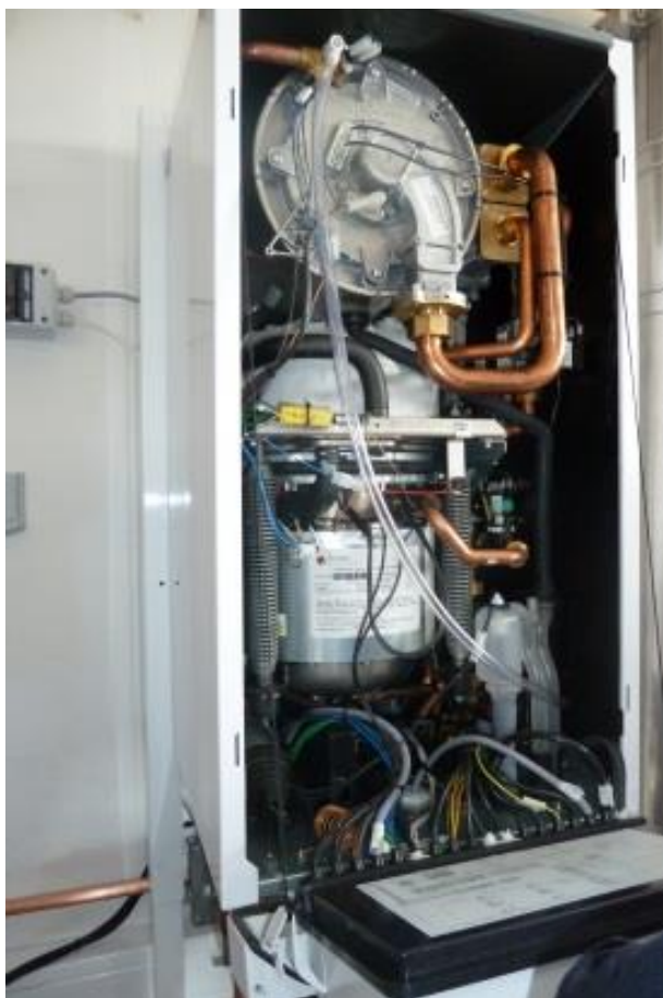
Obr. 14 KVET se Stirlingovým motorem v kompletu s plynovým kondenzačním kotlem
