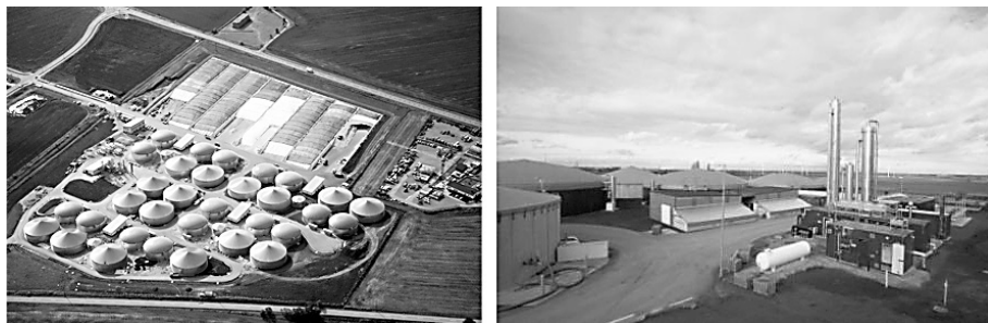
Obrázek 33 – Bioplynová stanice Könnern – celkový pohled, zařízení na úpravu bioplynu na biometan (vpravo)
