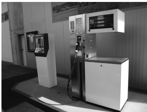
Obrázek 27 – Platební terminál a výdejní stojan u BioCNG stanice Margarethen am Moos
