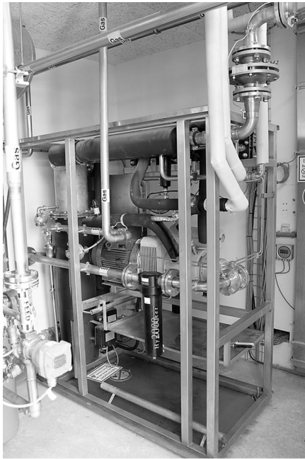
Obrázek 37 – Zařízení na úpravu bioplynu, měření
