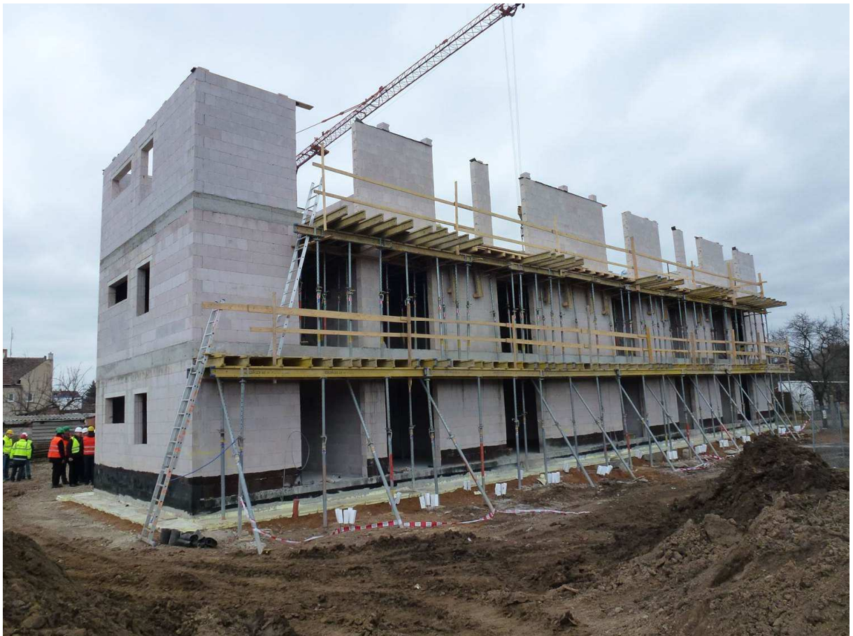
Hrubá stavba pasivního bytového domu
