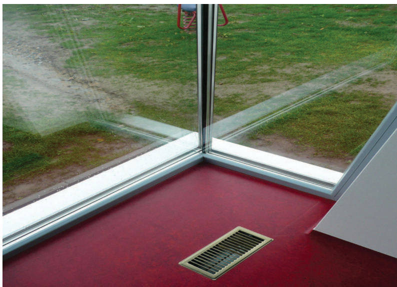
Obr. 13 Pasivní „Dům snů“ (z televizního pořadu). Detail zasklení výkladců s trojskly v nároží, v bezrámovém provedení. Architekt: Smola, spolupráce: Mertenová.
