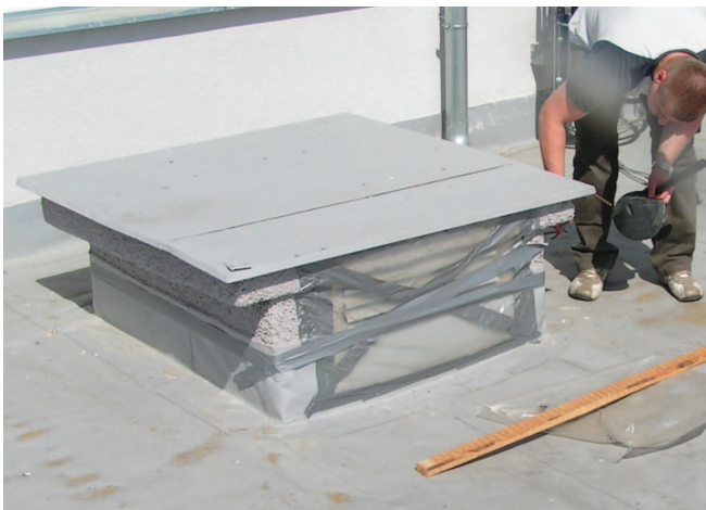
Obr. 3 Způsob utěsnění větracích otvorů střešních nástaveb.
