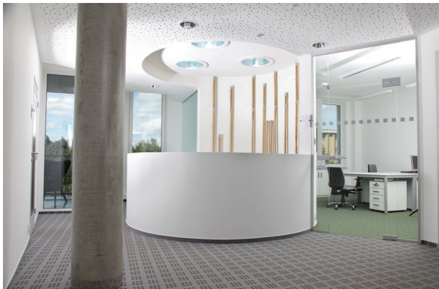
Obr. 3 Chodba 4NP – pohled na světlovody.
