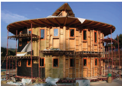
Obr. 2 Detail skladby stěny přístavby v Nenačovicích, nakonec jen s vrstvenou izolací / postup výstavby.
