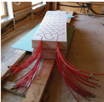
Obr. 3 Vykurovacie a chladiace plochy.
