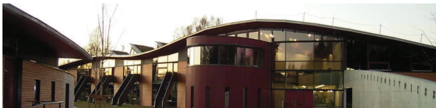
Obr. 14 Jižní strana se vstupem a s vnějšími schody do tříd (Foto aw vallengin)
