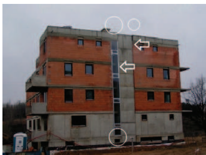
Obr.1 Stav budovy v okamžiku zadání úkolu s vyznačením dilatační spáry podél výtahové šachty.
