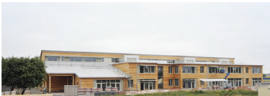
Obr. 4 Základná škola Oakmeadow: južná fasáda.
