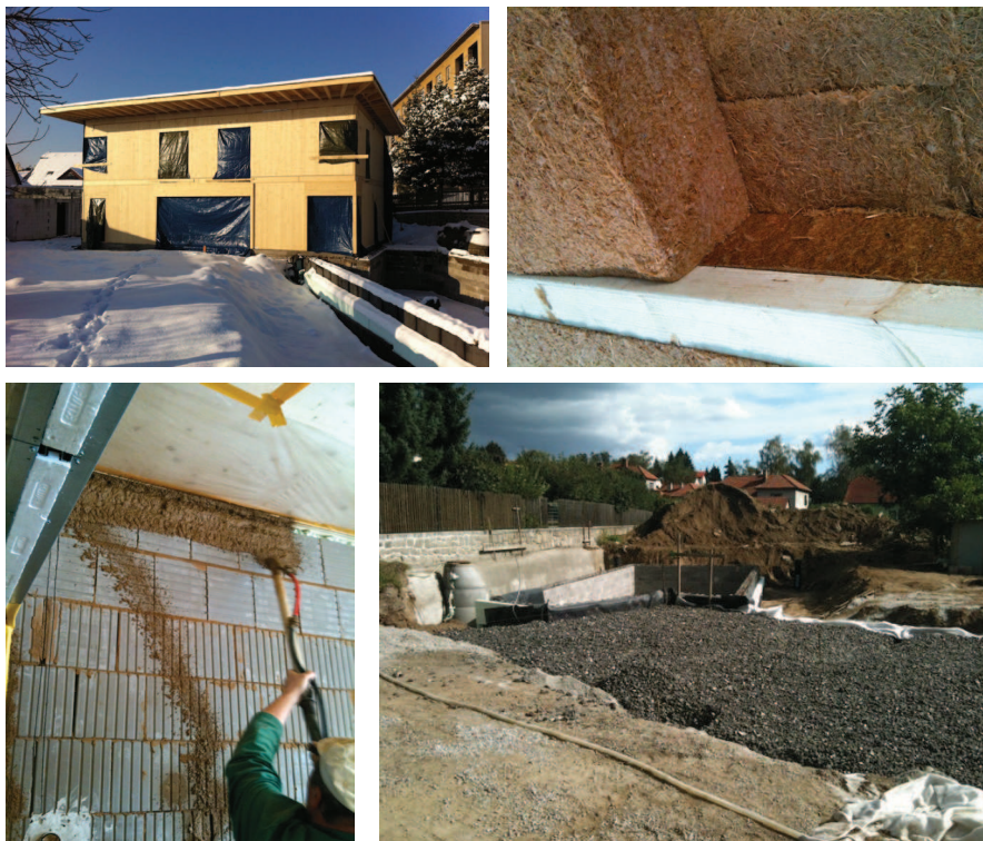
Obr. 1 Použité materiály dřeva, dřevovláknité izolace, hliněných cihel a omítek a pěnového skla
