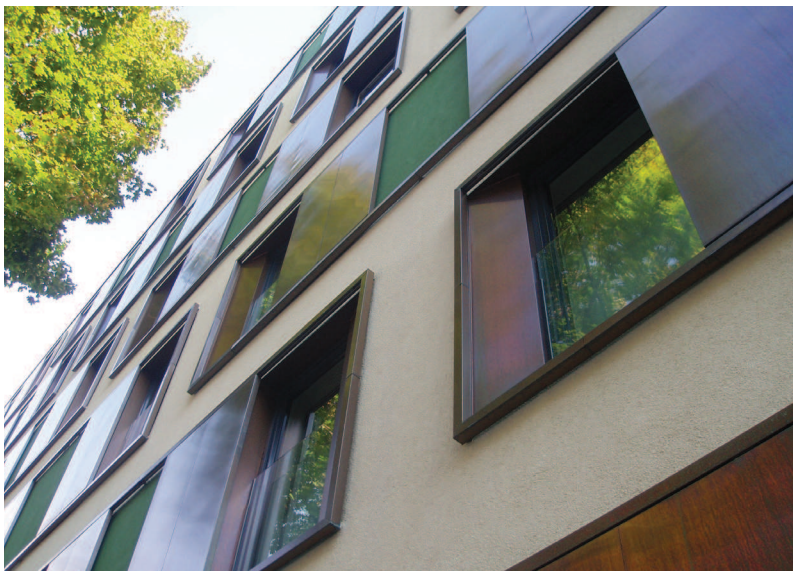
Obr. 14 Studentská kolej ve Vídni v pasivním standardu. Detail fasády s profilovaným ostěním a „mozaikou“ měděných stínících posuvných panelů. Architekti: Baumschlager, Ebrle.
