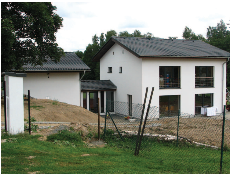
Obr. 5 Velmi kvalitní dům, těsně nad certifikovatelnou hranicí, dle definitivního přepočtu PHPP po dokončení stavby 17 \text{ kWh}/(\text{m}^2\text{a}) . Dle měření v sezoně 2010/2011: 15 \text{ kWh}/(\text{m}^2\text{a}) . Obec Hromnice, foto Ing. Martin Konečný, projektový návrh. Ing. Štěpánka Hamatová .
