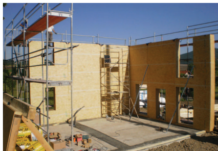
Obr. 1 Montáž domu po 2 hodinách.
