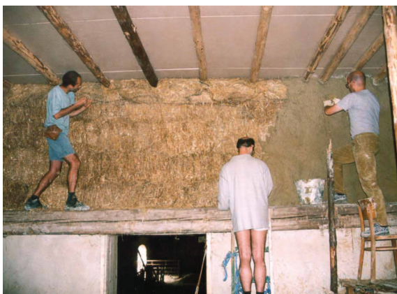
Obr. 1 Průběh stavby, rabicování i omítání ve stodole v Židovicích.
