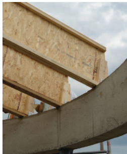
Abb.4: Beispiel: Passivhaustaugliche Traufe
