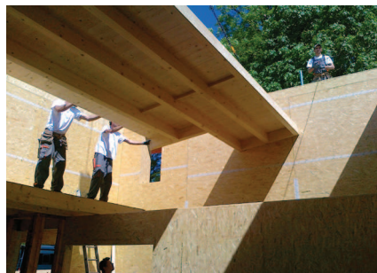
Obr. 2 Vkladanie hotových stropných dielcov po prepečení špár.
