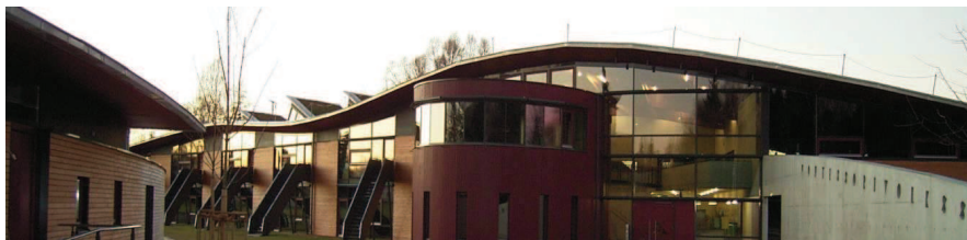
Abb.14 Südseite mit Eingang und den Außentreppen der Klassenräumen (Foto aw vallengin).
