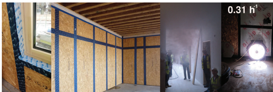
Obr.11 Základná škola Oakmeadow: detaily, test vzduchotesnosti - blower door test.
