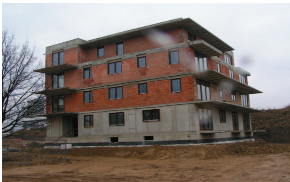
Obr. 2 Stav objektu v době rozhodnutí o změně energetického standardu.
