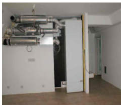
Obnažený větrací systém.
