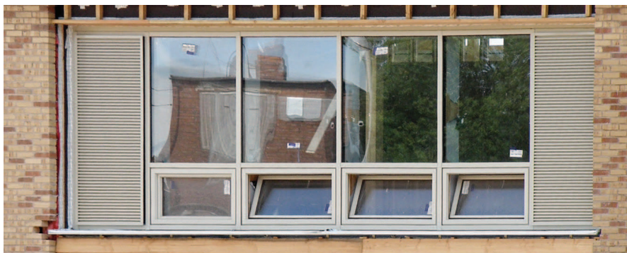
Obr. 10 Základná škola Bushbury: výplň okenného otvoru v triede: fixné zasklenia, malé manuálne otváracie okná a bezpečnostné žalúzie pre vetranie a chladenie.
