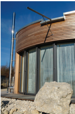
Abb.4: Beispiel: Passivhaustaugliche Traufe
