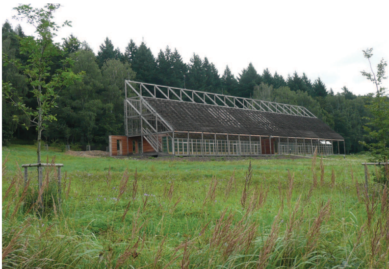
Obr. 17 Lesovna Písek, realizována na základě vyzvané architektonické soutěže. Oproti soutěžním podmínkám byla cena takřka trojnásobná. O splnění požadavku, nízké energetické náročnosti nelze u plně prosklené stavby hovořit. Výtvarně zajímavé dílo je učebnicovým příkladem nerespektování pravidel konstrukční ochrany dřeva a právních předpisů. Architekt: Rajniš.
