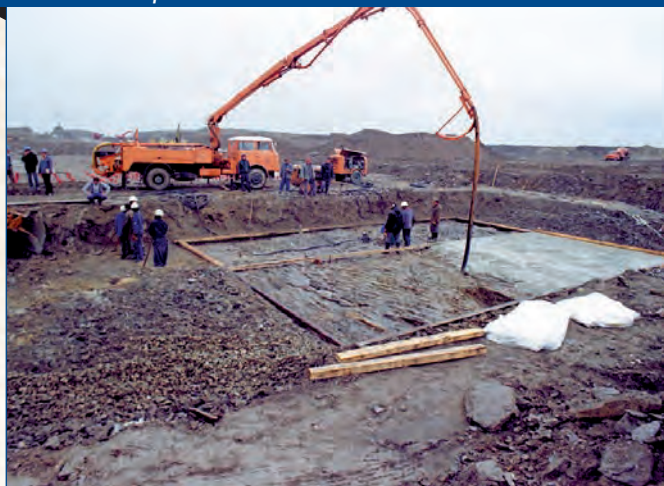
Betonování základů pro JE Temelín
