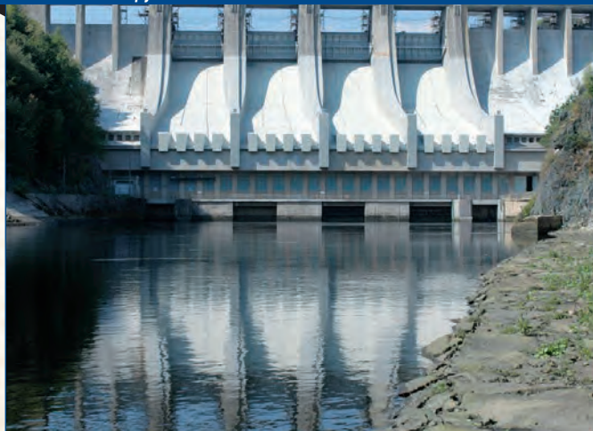
Vodní elektrárna Slapy
