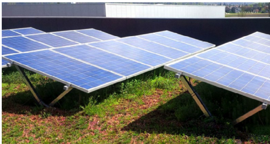
Obrázek 5 Zelená střecha zvyšuje účinnost fotovoltaiky. Fotovoltaika na druhou stranu podporuje biodiverzitu na zelené střeše. Zdroj: Baulinks 18
