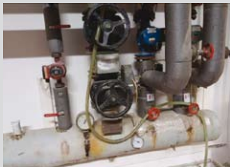
↑ Rozdělovač - hlavní kotelna
