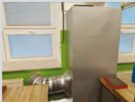
Obrázek 23: Rekuperační jednotka
