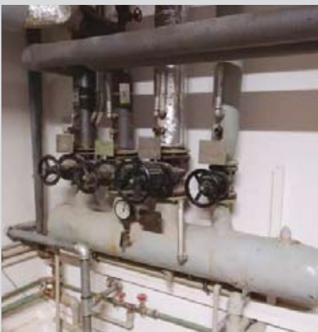
↑ Sběrač - hlavní kotelna
