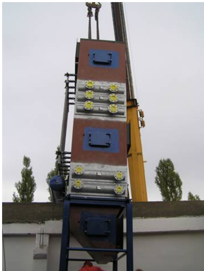
Obr.4 - Instalace olejového a vodního ekonomizéru
