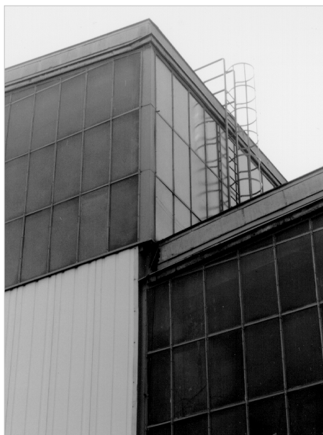
Obrázek 1 – Detail ocelo-plechového obvodového pláště výrobní haly V17 Škoda a.s. M. Boleslav
