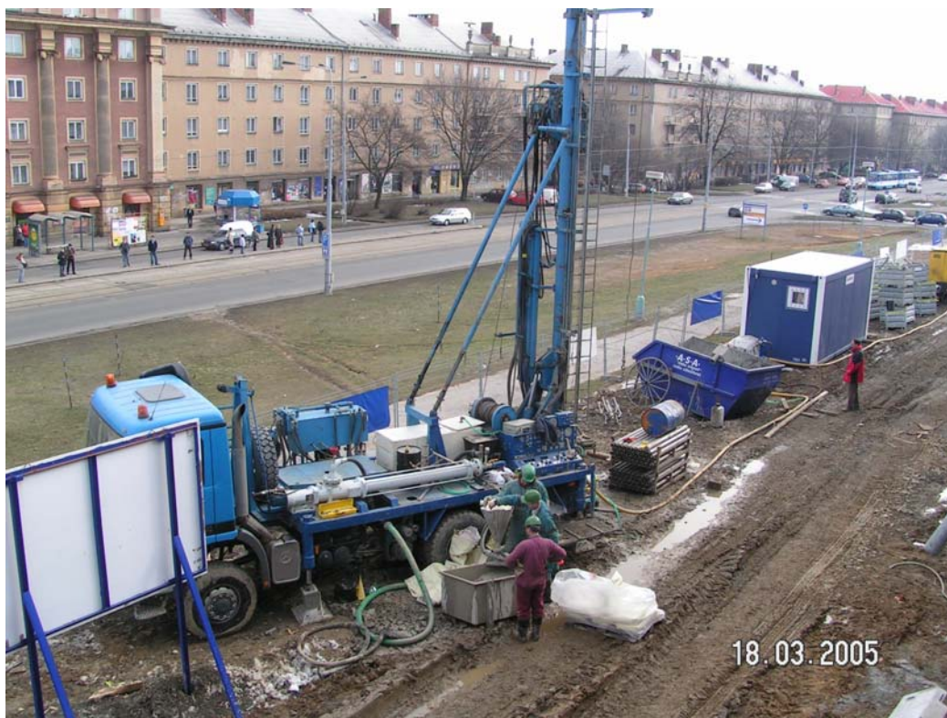
Obr. č. 14. Injektáž zkušebního vrtu č. 2 pomocí speciální injektážní směsi STÚWATERM 2000Z
