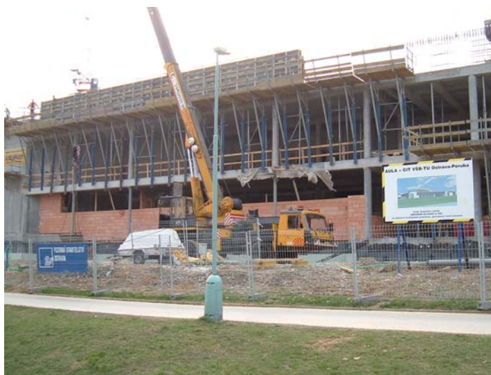
Vrt č.2, Ostrava
