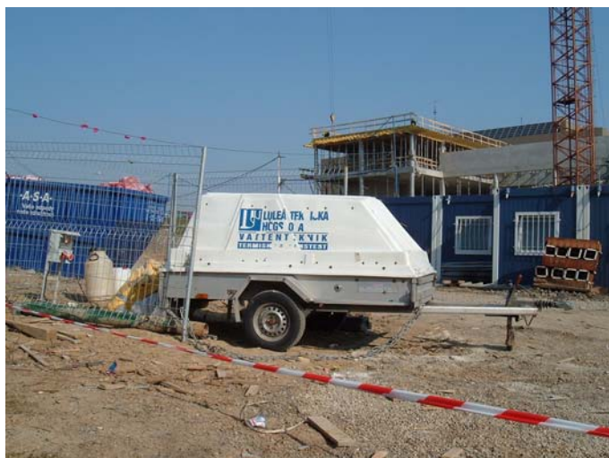
Vrt č.1, Ostrava
