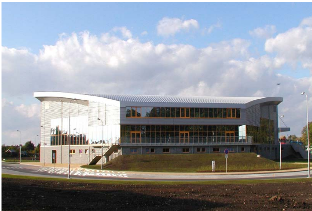
Obr. 9. Městská víceúčelová sportovní hala v Opavě vytápěná pomocí tepelných čerpadel s vrty
