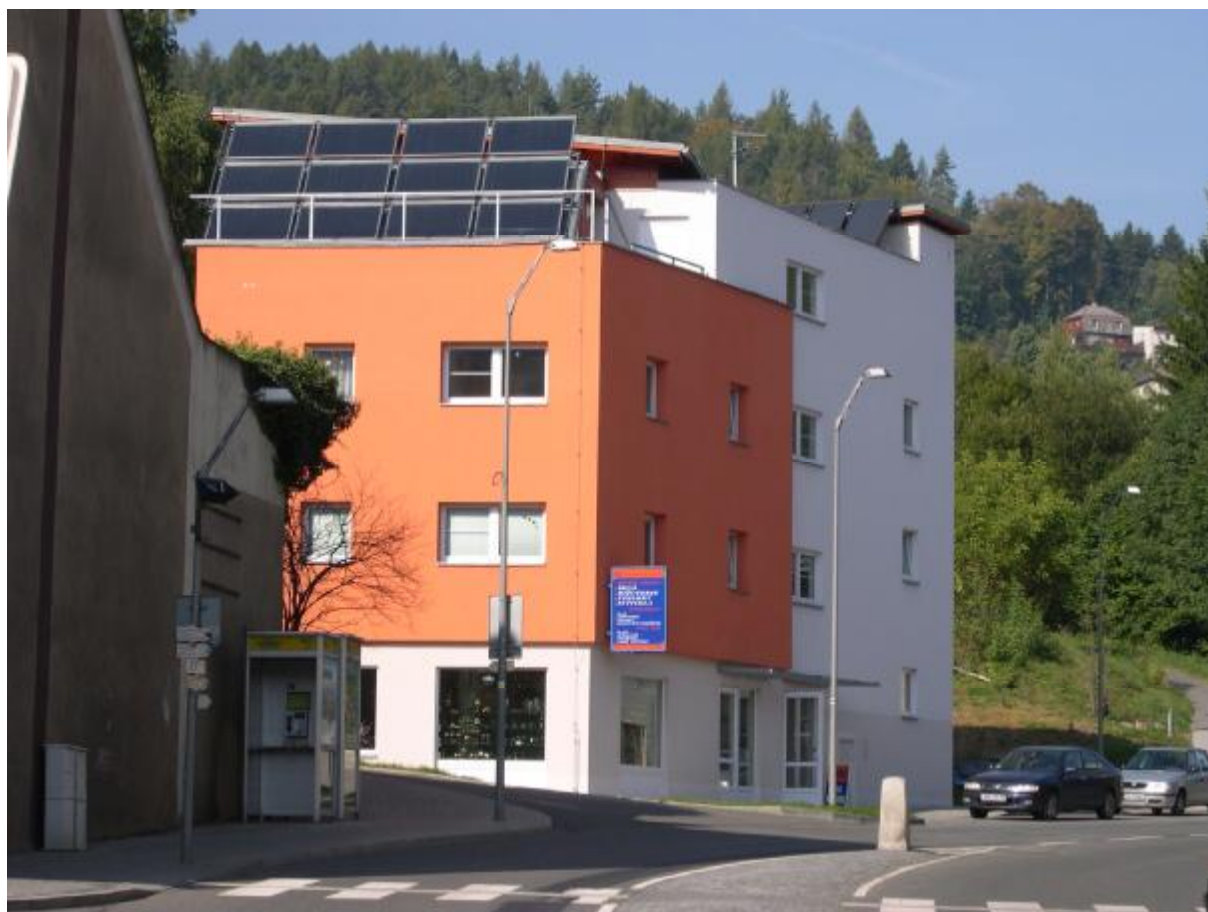
Foto – provedení kolektorů na střeše
