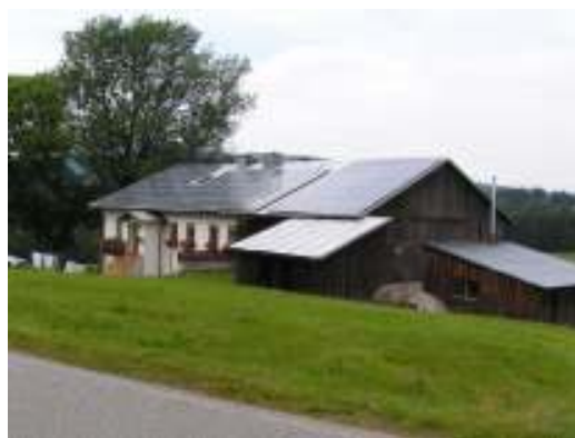
RD vybavený 37 m 2 kolektorů – systém s akumulací el. energie
