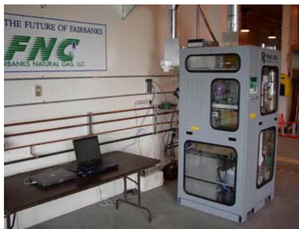
Obrázek 10-5 Příklad možného použití jednotky 5 kW firem Fuel Cell Technologies Ltd a Siemens Power Generation jako zdroje elektrické energie a tepla pro domácnost (vlevo) a pro podnik (vpravo).
