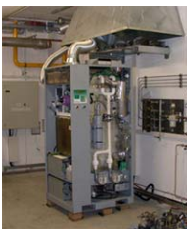
Obrázek 10-5 Příklad možného použití jednotky 5 kW firem Fuel Cell Technologies Ltd a Siemens Power Generation jako zdroje elektrické energie a tepla pro domácnost (vlevo) a pro podnik (vpravo).
