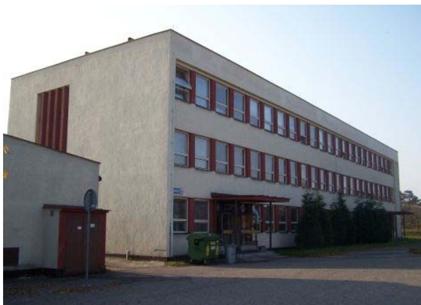
Obrázek 10-1 Průčelí objektu Krásnopolská č.p. 86 s částí objektu kotelny po levé straně.
