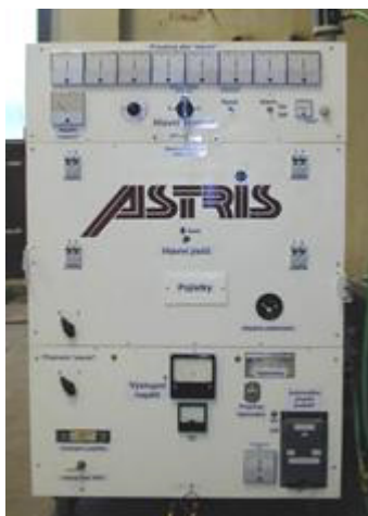
OBR. 3.21 KOGENERACNÍ JEDNOTKA S PALIVOVÝMI ČLÁNKY O VÝKONU 4 KW
