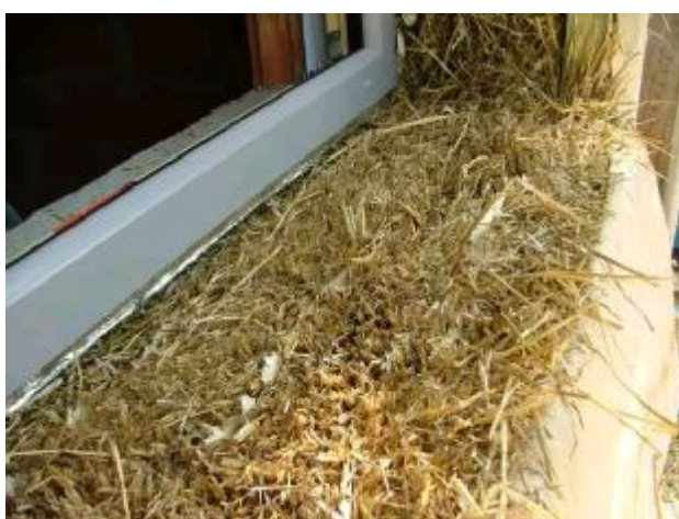
Obrázek 16: Některé stěny jsou izolovány slámou
