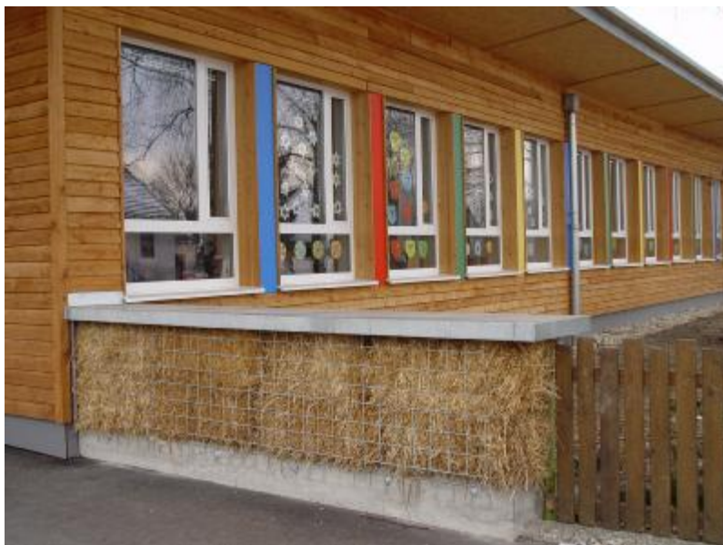
Obrázek 11: Základní škola v rakouském Absdorfu při rekonstrukci se pro zateplení použily balíky slámy
