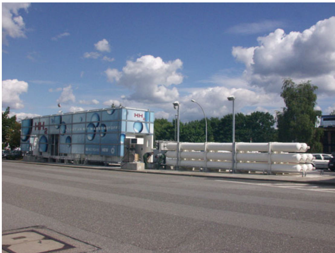
Obrázek 56: Čerpací stanice v Hamburku
