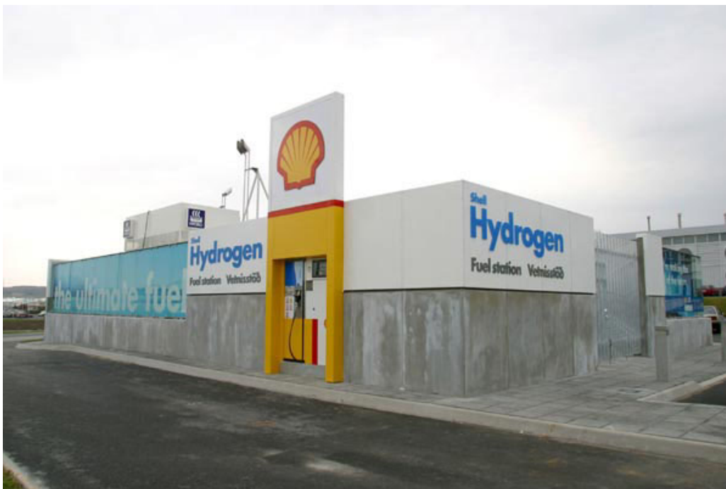
Obrázek 59: Čerpací stanice na Islandu
