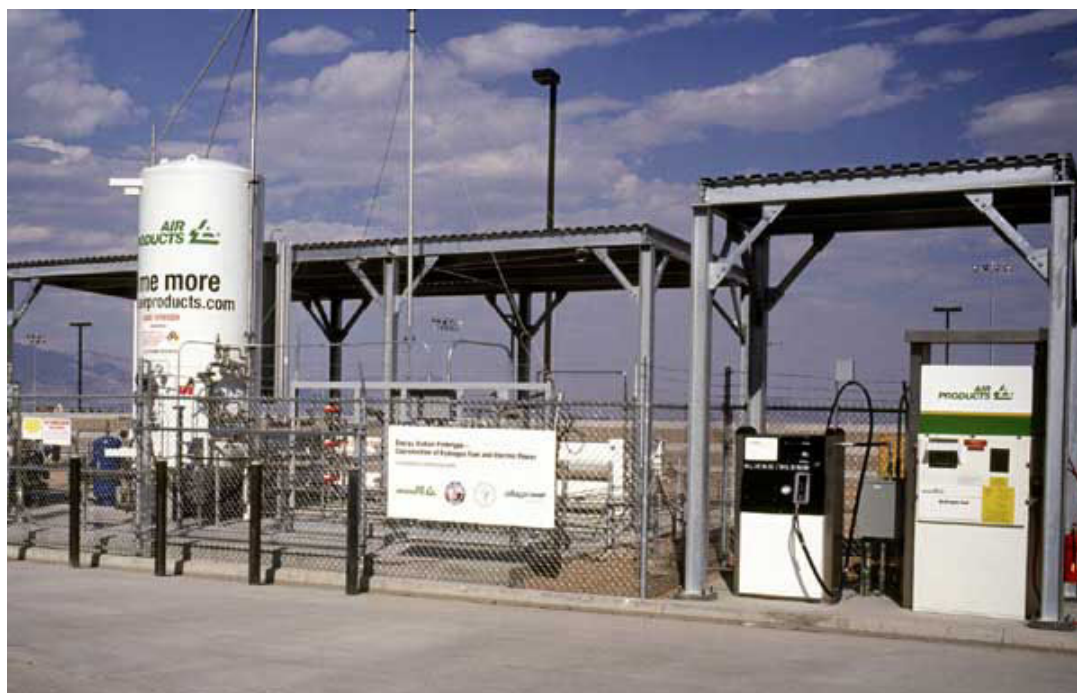
Obrázek 58: Čerpací stanice v Las Vegas
