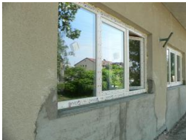
Obrázek 22: Okno s otevíravou a pevně zasklenou částí
