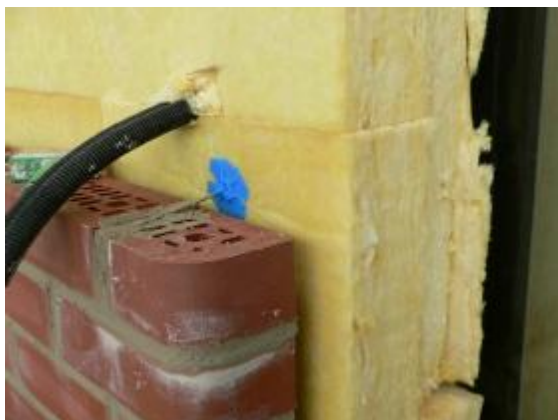
Obrázek 14: Zateplení s odvětranou mezerou
