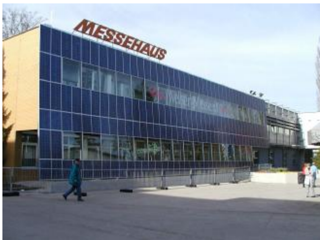
Obrázek 56: Budova s fotovoltaickou fasádou (Wels, Rakousko).
