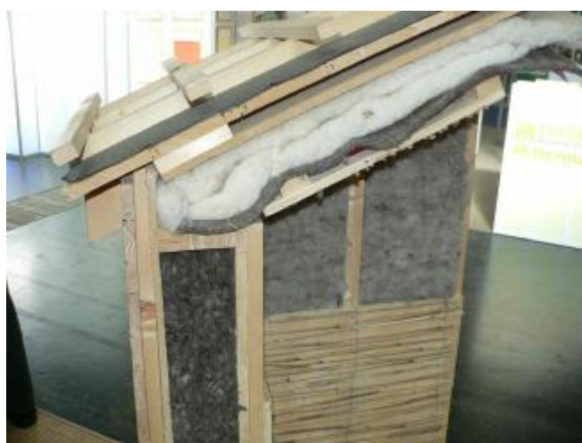
Obrázek 9: Pro izolaci lze použít i ovčí vlnu.
