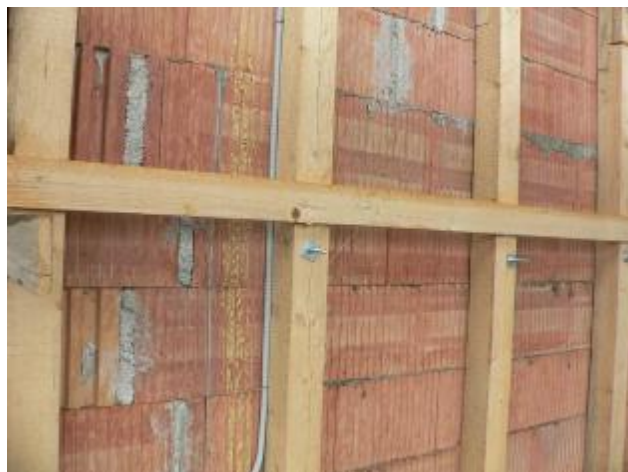
Obrázek 16: Nosný dřevěný rošt pro izolaci
