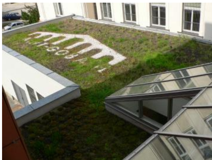
Obrázek 13: Zelená střecha s extenzivní zelení.
