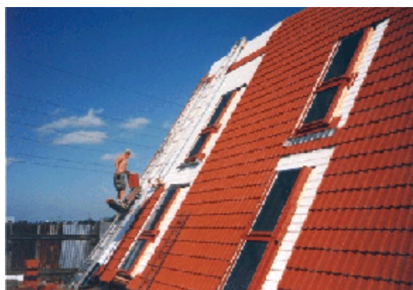
Obrázek 7: Tepelná izolace podkroví systémem TERMODACH
