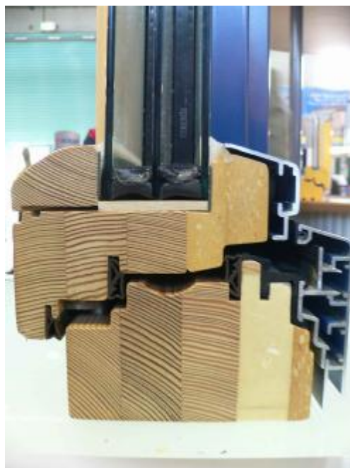
Obrázek 23: Okno s trojsklem a zlepšenou izolací rámu
