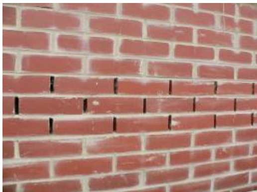
Obrázek 15: Odvětrání mezery otvory v lícovém zdivu
