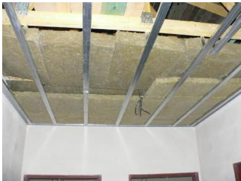
Obrázek 6: Tepelnou izolaci lze výhodně vložit do podhledu.
