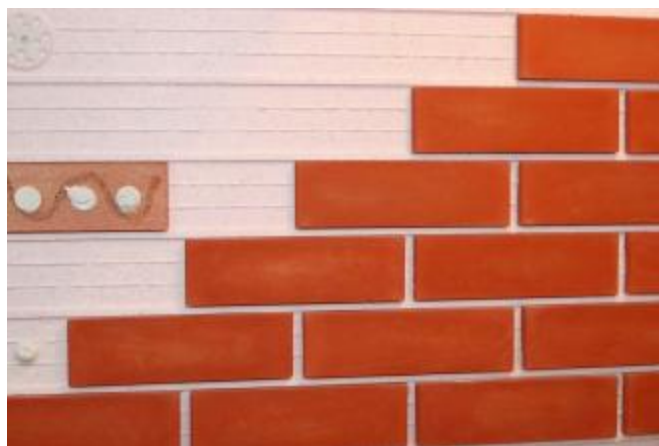
Obrázek 17: Kontaktní zateplení lze opatřit i keramickým obkladem
