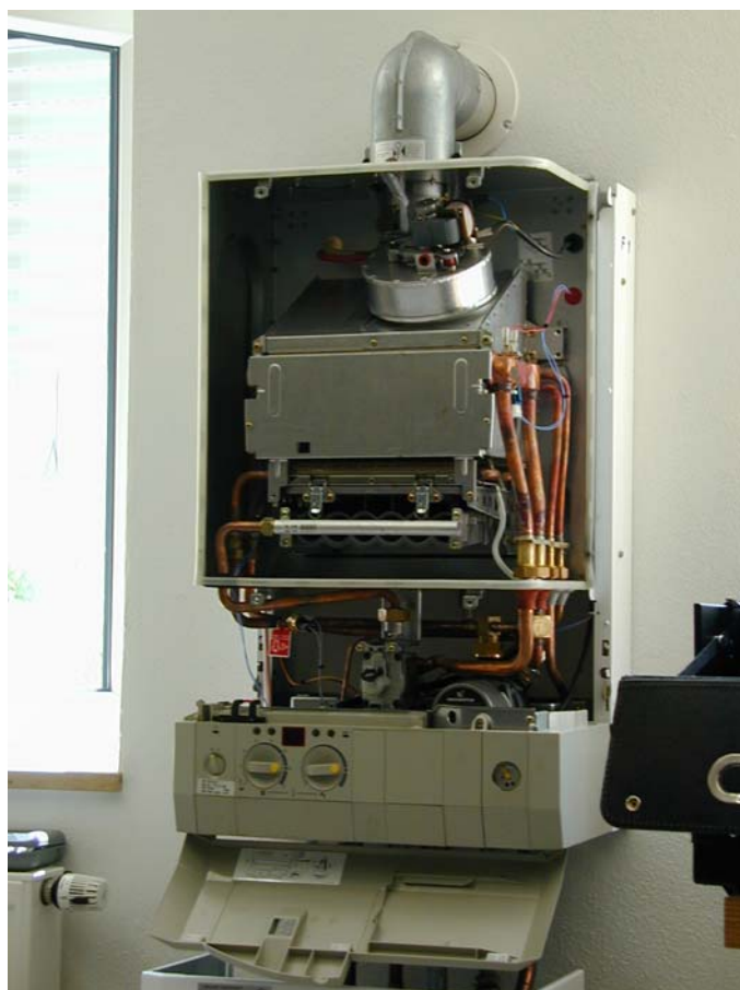
Obrázek 8 – Princip uspořádání kondenzačního kotle s přetlakovým hořákem
