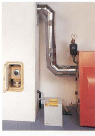
Obrázek 10 – Měřicí otvor u kotlů s přetlakovým hořákem se provede hned za spalino- vým hrdlem kotle
