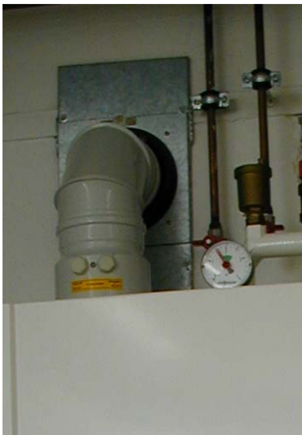
Obrázek 12 – Na obrázku jsou dva otvory pro měření na kouřovém hrdle kondenzačního kotle uzavřené víčkem. Jeden otvor je v průduchu koncentrického přívodu vzduchu, druhý otvor je v kouřovodu.
