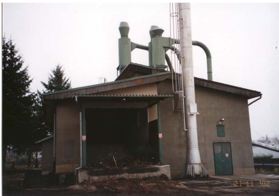
Pohled na rekonstruovanou výtopnu
