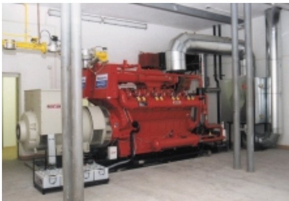
Obrázek 5: Kogenerační jednotka se spalovacím motorem, teplárna Studénka v Nové Pace. (Zdroj: Motorgas, s r.o.)
