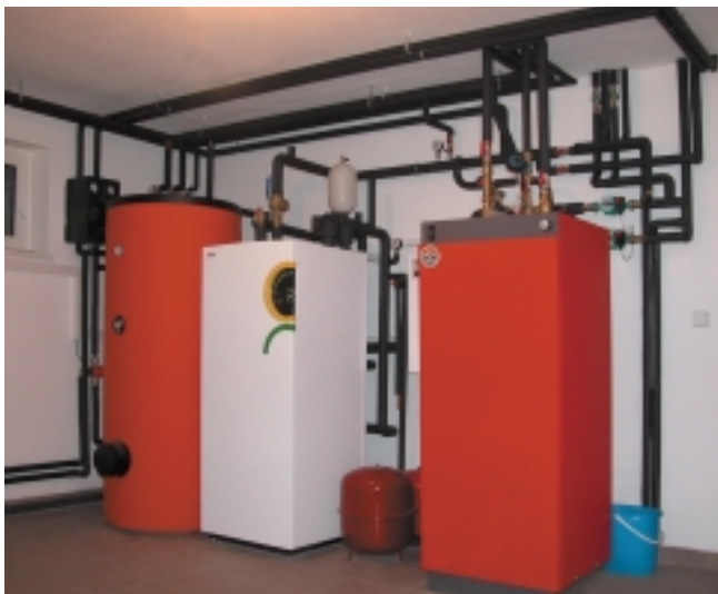
Obrázek 9: Kotelna s 16 kW TČ. (Zdroj: Alterm s.r.o.)
