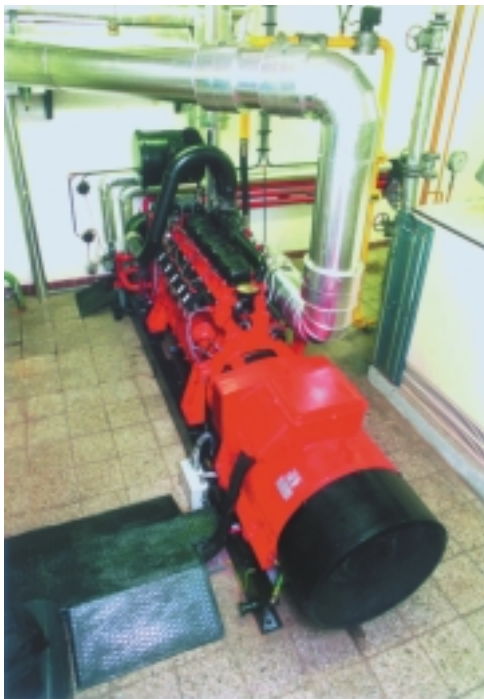
Obrázek 7: Pohled zhora na kogenerační jednotku s plynovým motorem. (Zdroj: Motorgas, s r.o.)
