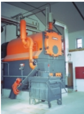
Obrázek 3: Kotel na spalování dřevní štěpky ve výtopně Schenkenfelden, Horní Rakousko.
