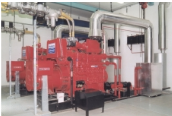
Obrázek 3: Kogenerační jednotka se spalovacím motorem ČOV Ústí n. Labem. (Zdroj: Motorgas, s r.o.)
