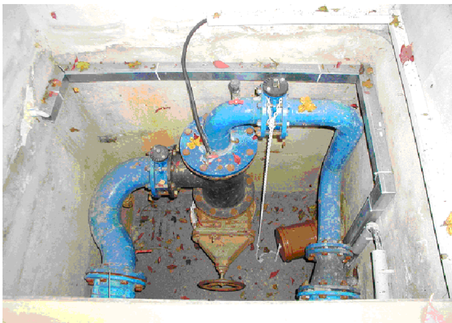
Zhlaví provedeného vrtu
