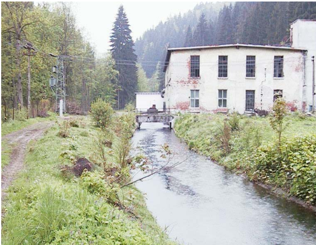
Celkový pohled na MVE
